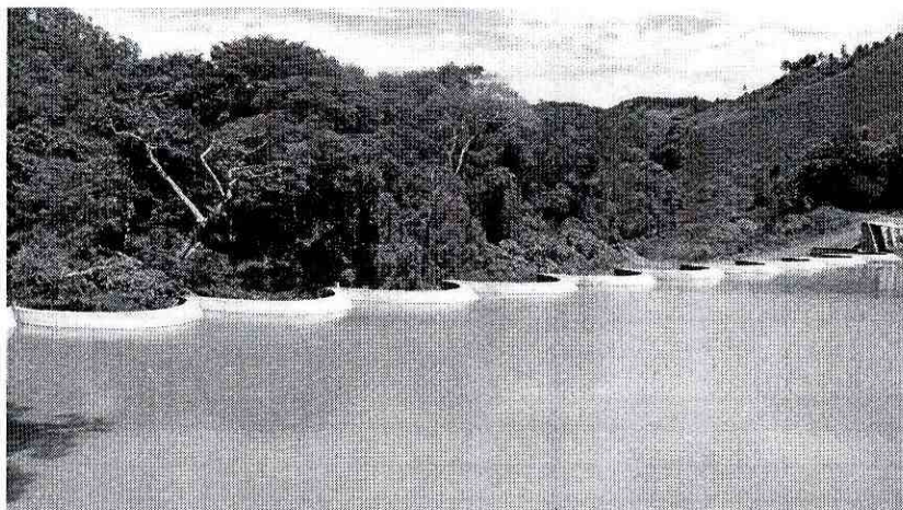
Ilustración 58: Hidroeléctrica Poza Verde
