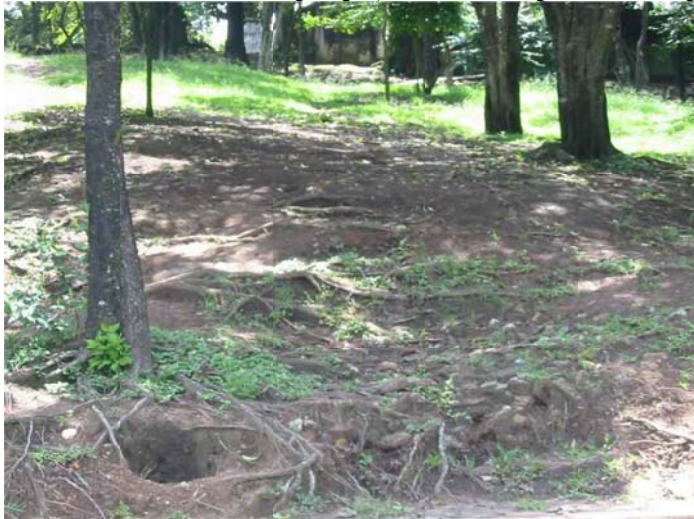
Figura 8 Erosión en el suelo del parque, con raíces superficiales expuestas
