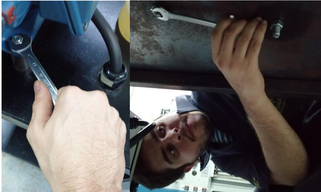
Ilustración 6. Forma correcta de apretar los tornillos de los elementos a la estructura.
