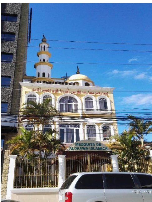
Fotografía 3: Fachada de la mezquita de Aldaawa
