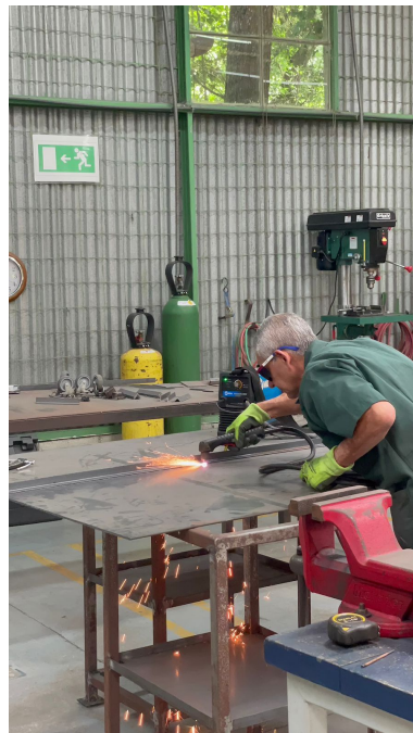
Figura 57: Cortado de paneles con cortadora plasma
