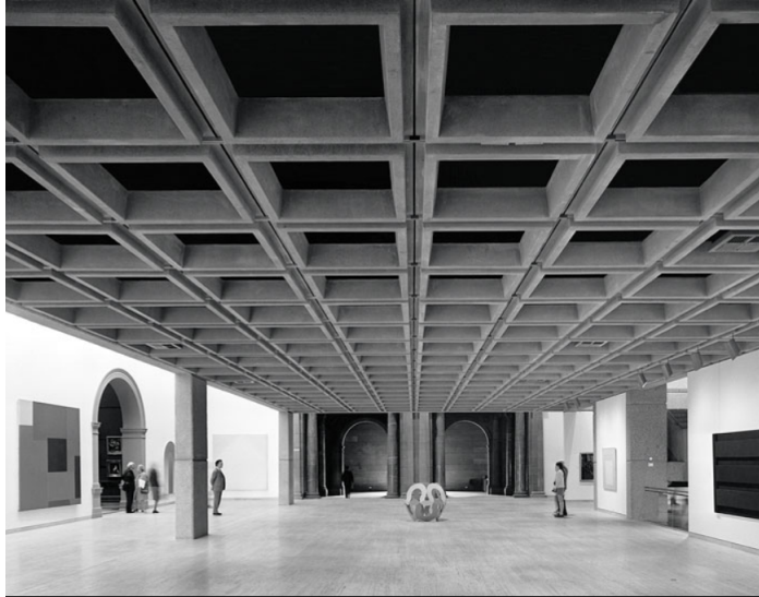
Figura 2: Losa aligerada reticulada [8]
