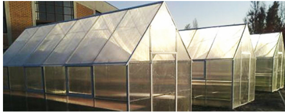
Figura 5: Cubierta traslúcida de un invernadero
