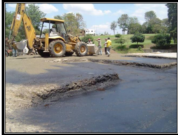
Figura No. 17 Retroexcavadora y plataformas imprimadas
