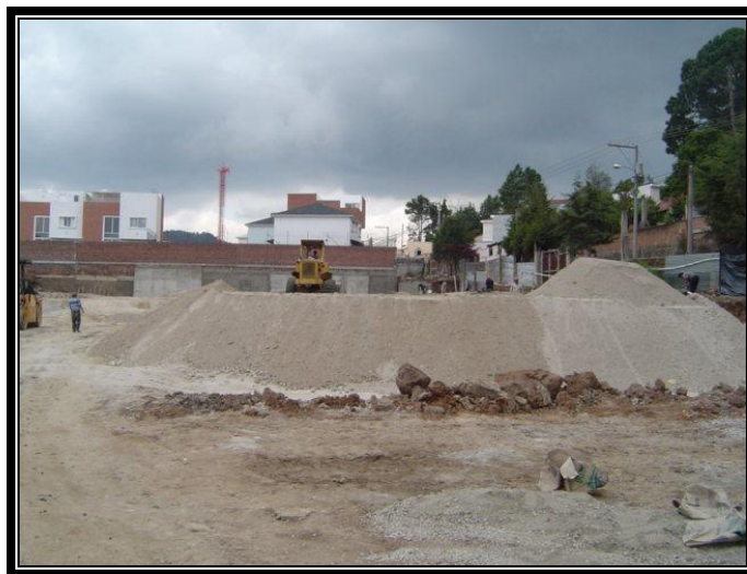
Figura No. 9 Conformación de plataforma
