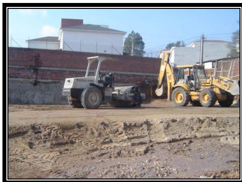
Figura No. 11 Rodo vibratorio y retroexcavadora
