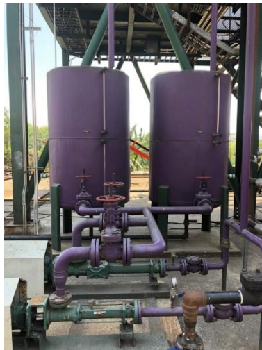
Ilustración 17: Tanques de floculante
