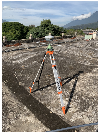
Figura 38: Instalación de la base en el techo de la Municipalidad
