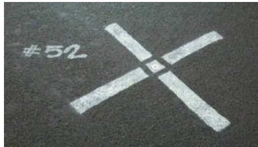
Figura 34: Utilización de pintura en aerosol para puntos de control
