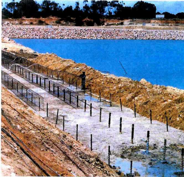
Figura 9. Cimentación de muelle
