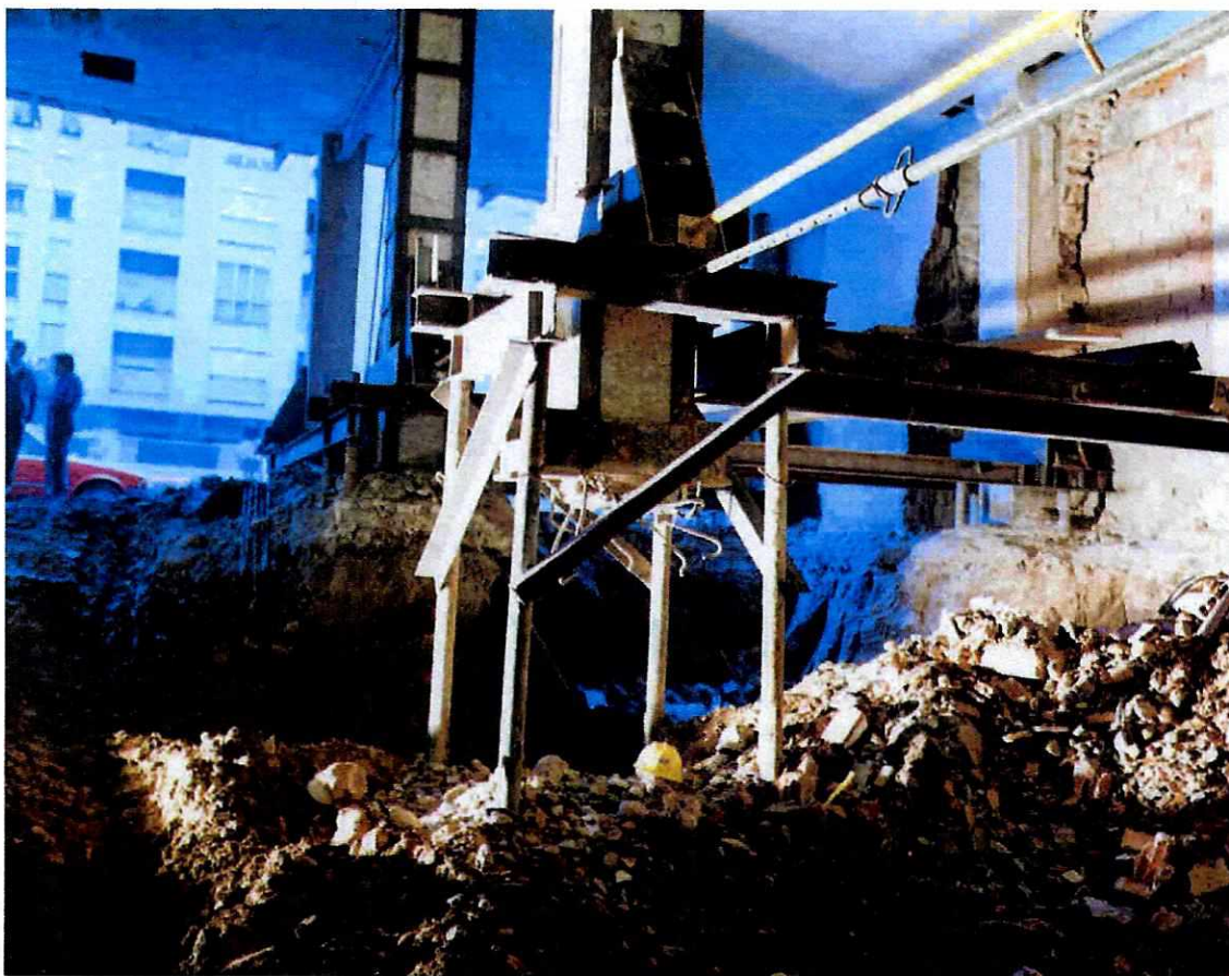
Figura 3. Recalce de cimentación con utilización de micropilotes
