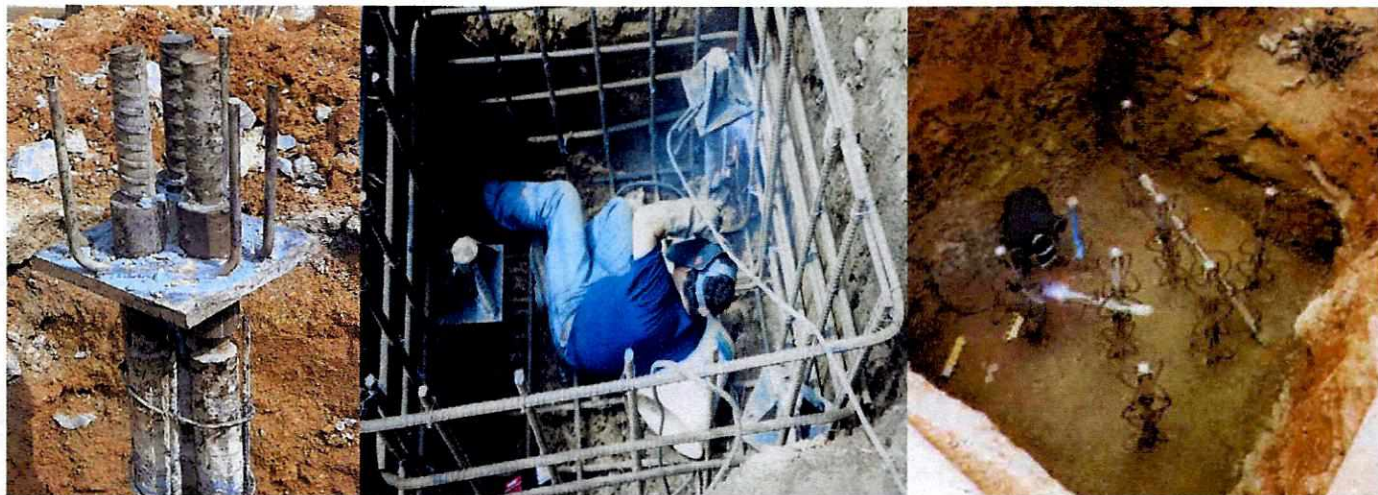
Figuras 25. Diferentes tipos de detalles de cabezas para micropilotes
