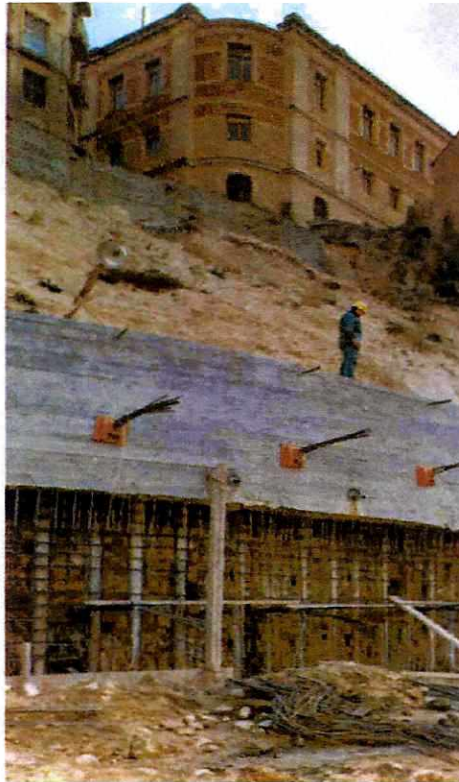
Figura 11. Pantalla de micropilotes
