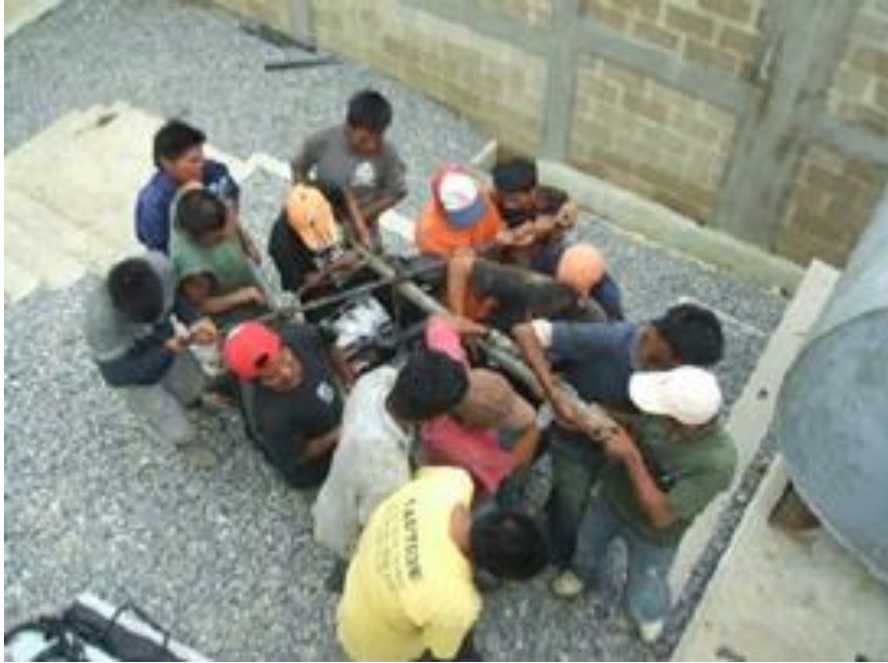
Ilustración 19: Armado del motogenerador en el sitio
