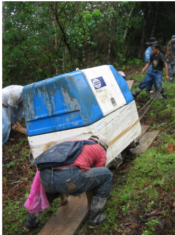
Ilustración 55: Personal colocando madera debajo del motogenerador para facilitar su movimiento
