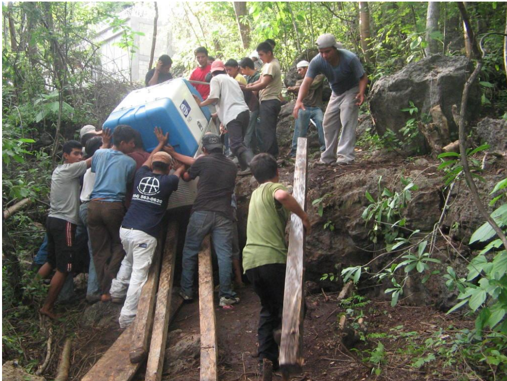
Ilustración 41: Personal se ayuda con madera para subir motogenerador
