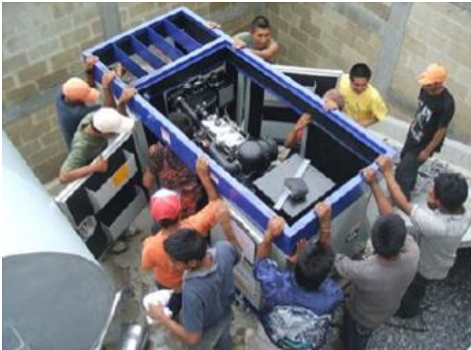
Ilustración 19: Armado del motogenerador en el sitio
