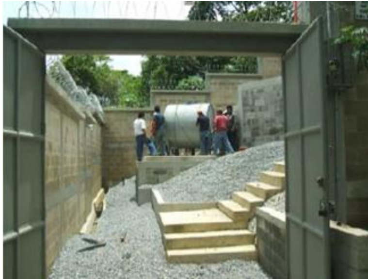
Ilustración 12: Colocación del tanque mensual en el sitio
