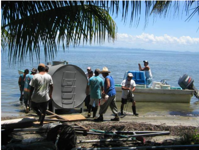
Ilustración 50: Acarreo de tanque de diesel en lancha
