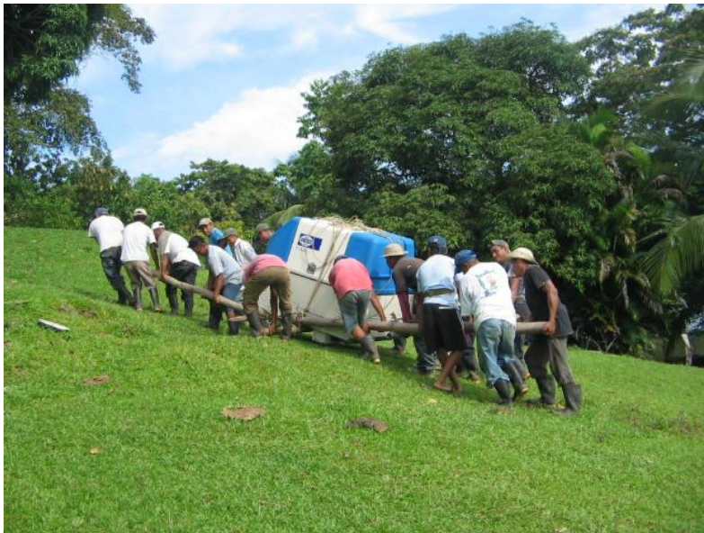
Ilustración 53: Acarreo del motogenerador por una pendiente
