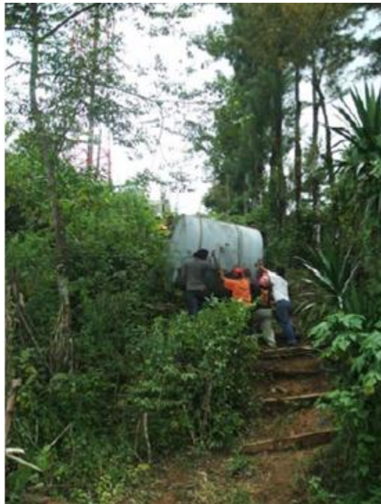
Ilustración 9: Personal subiendo el tanque a través del sendero de gradas improvisadas
