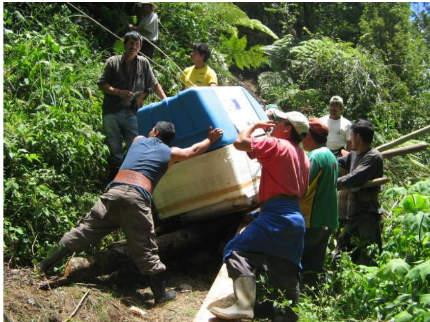
Ilustración 45: Personal levantando el motogenerador con troncos
