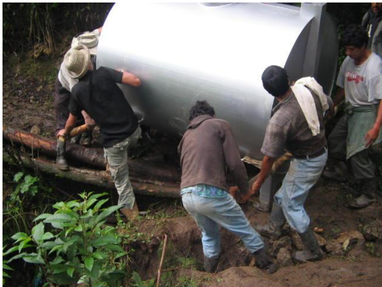
Ilustración 47: Personal pasando tanque de diesel por puente de troncos
