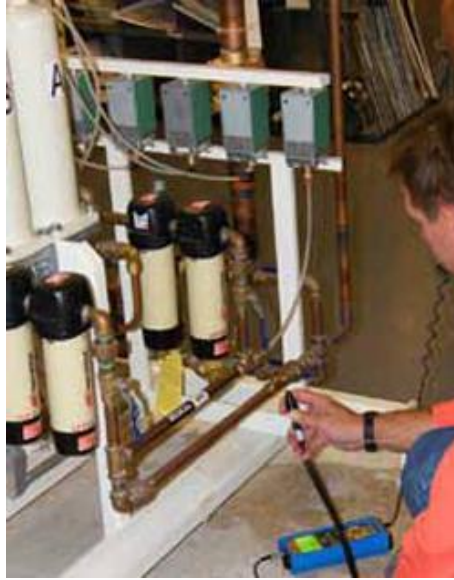
Figura 9. Inspección por ultrasonido en tuberías para revisión de fugas de aire comprimido
