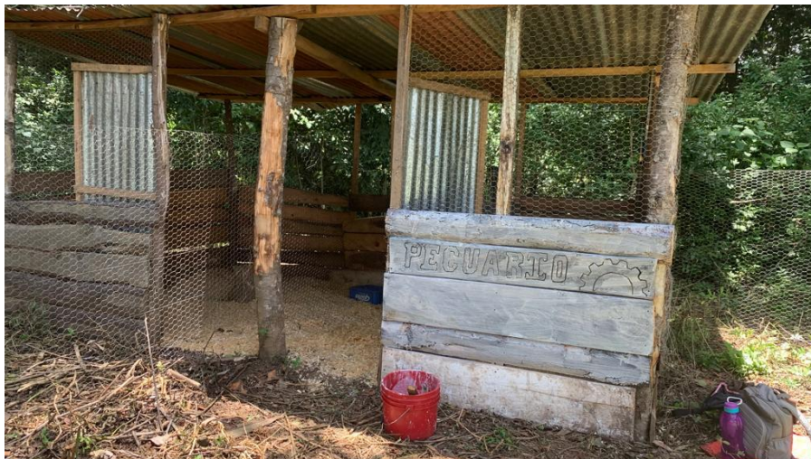
Ilustración 4. Construcción del galpón
