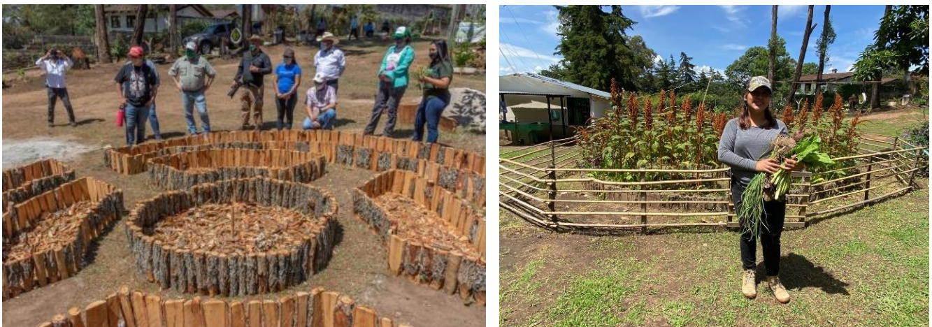
Figura 0-4: área hortícola, a) en proceso de construcción (Fotografía por J. Monzón); y b) área finalizada y primera cosecha (Fotografía por A. López).
