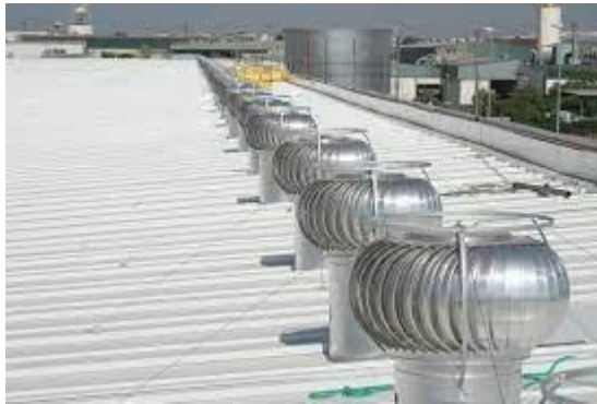
Ilustración 1. Ventilación eólica (Siber, 2023)
