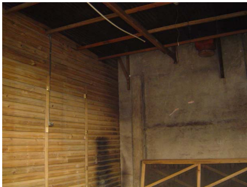
Figura 8. Interior de la cámara de secado
