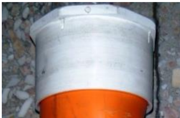
Figura 7.5. Detalle de adaptación de tapón
