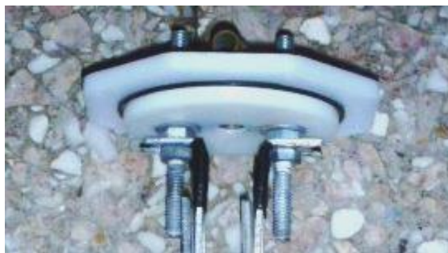
Figura 7.8. Detalle de tapadera de polímero, vista superior
