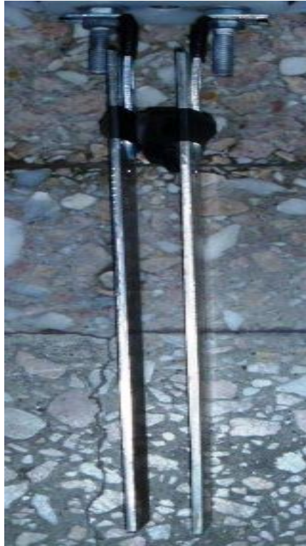
Figura 7.3. Detalle de platina sujeta a electrodo y tirante de acero inoxidable para sujetar a electrodo
