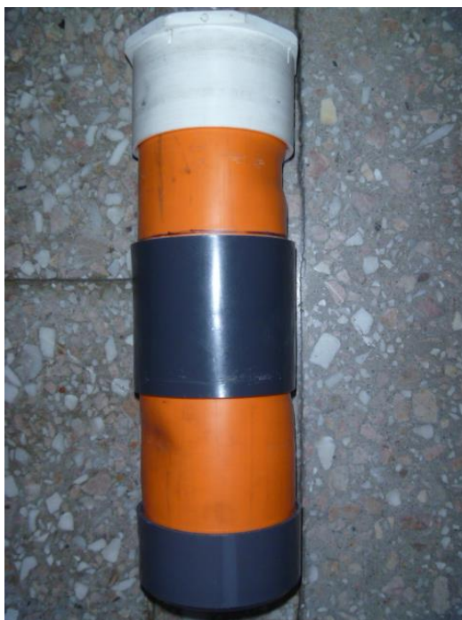
Figura 7.13. Detalle de las secciones de PVC, junta media, tapa inferior y complemento de la parte superior ya pegadas.
