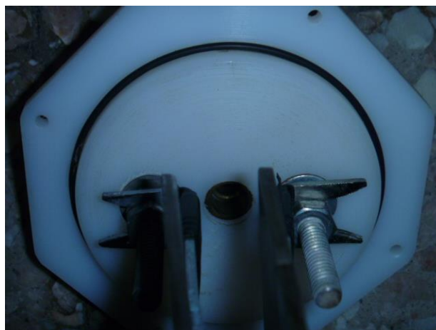
Figura 7.17. Detalle de oring instalado
