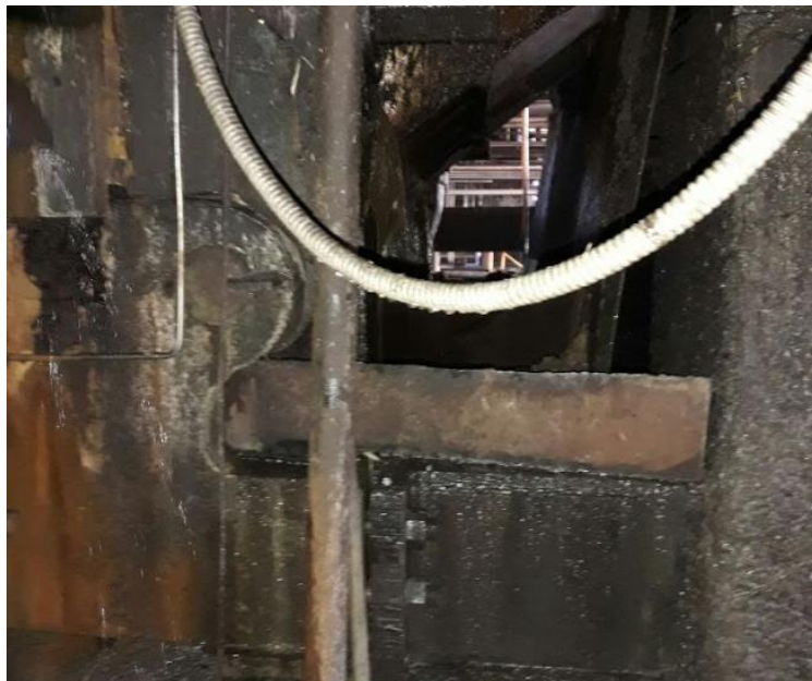
Figura No. 111. Barrera metálica colocada entre molino 1 y 2
