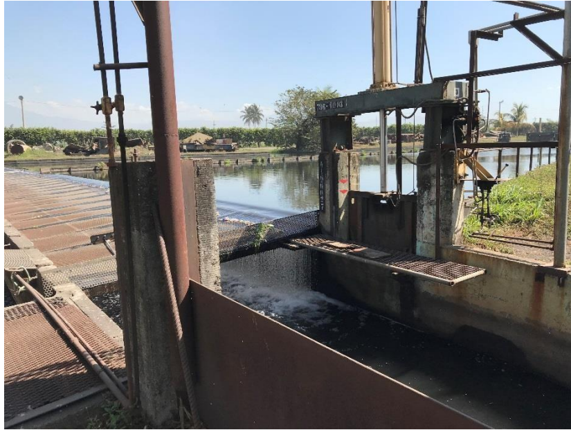
Figura No.24: Canal de entrada del ingenio azucarero
