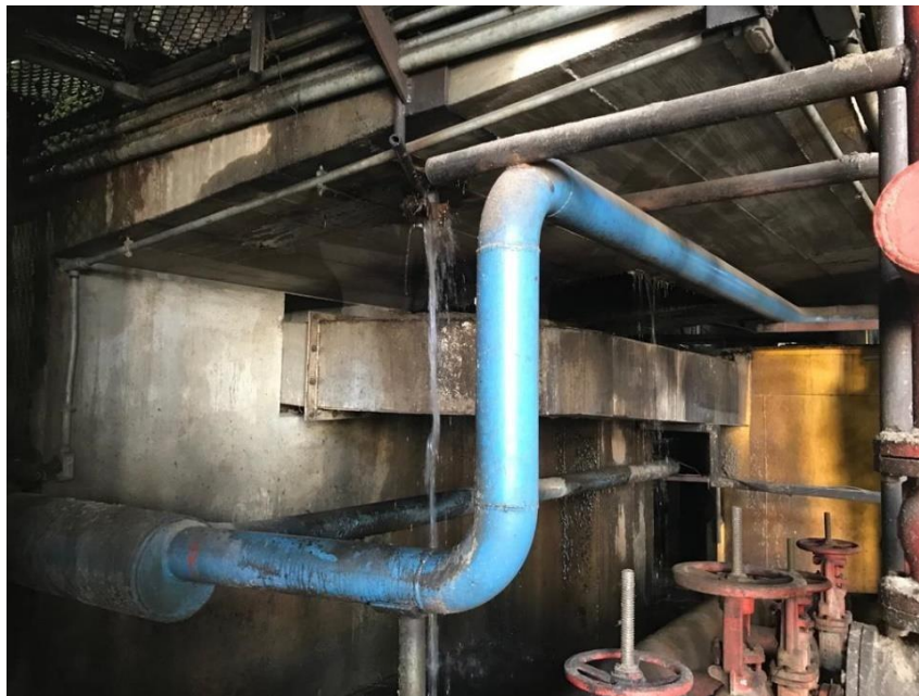
Figura No.137 Efluente de agua de enfriamiento para coronas de molinos
