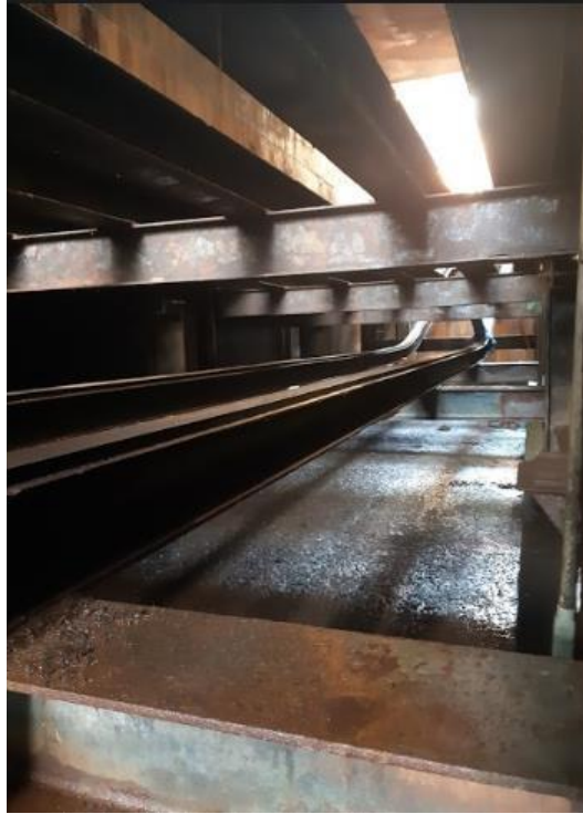
Figura No.116. Matajuntas y angulares en conductores
