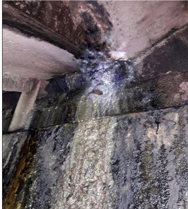
Figura No. 108. Fuga en tanque de jugo de caña
