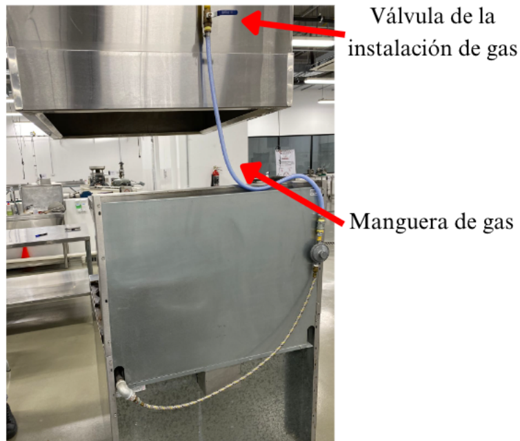
Imagen No.52: Parte trasera de la estufa industrial
