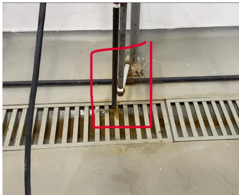
Imagen No.41: Tubería de condensado desconectada del colector de vapor
