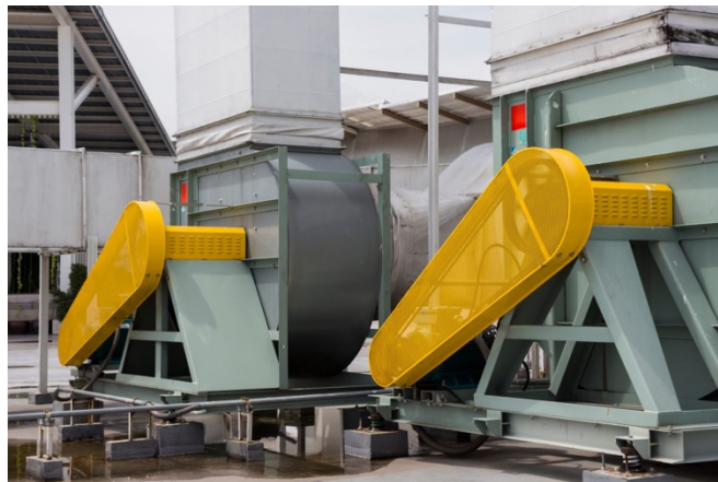
Imagen No.3: Guardas fijas
