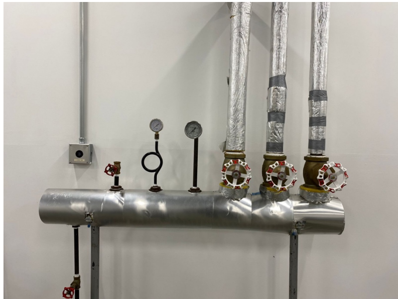
Imagen No.21: Instalación de vapor
