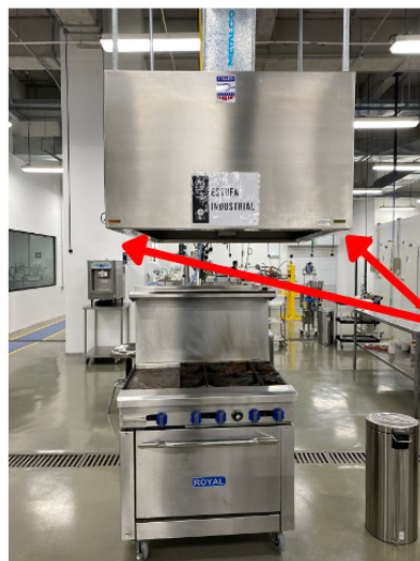
Imagen No.49: Salientes de la campana de la estufa industrial
