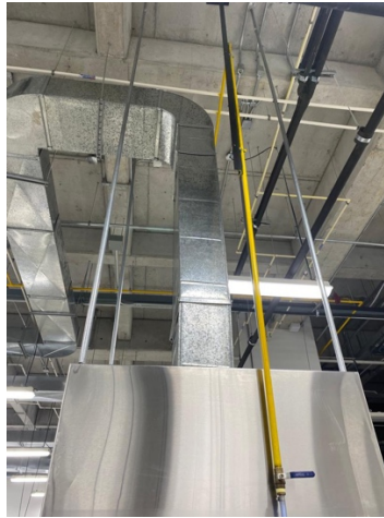
Imagen No.22: Instalación de gas
