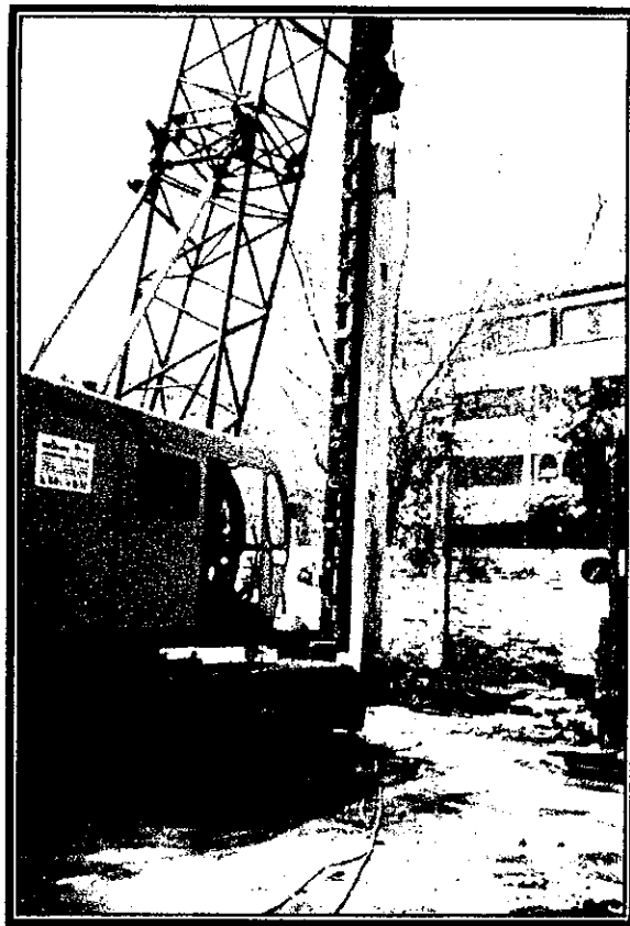
Foto # 3 Hincando pilote de concreto armado con martinete Delmag en México, D.F. (17).
