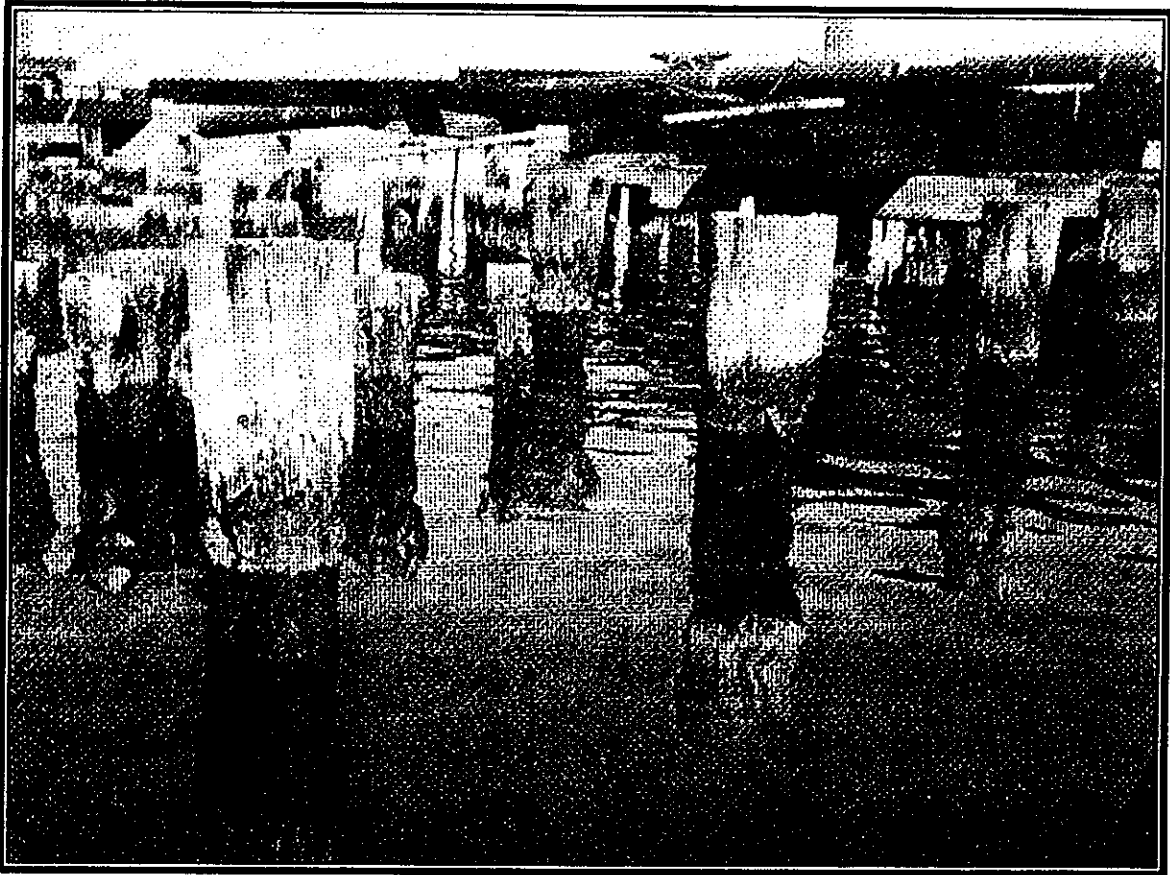
Foto # 1. Deterioro de pilotes de madera en zonas marinas (7).
