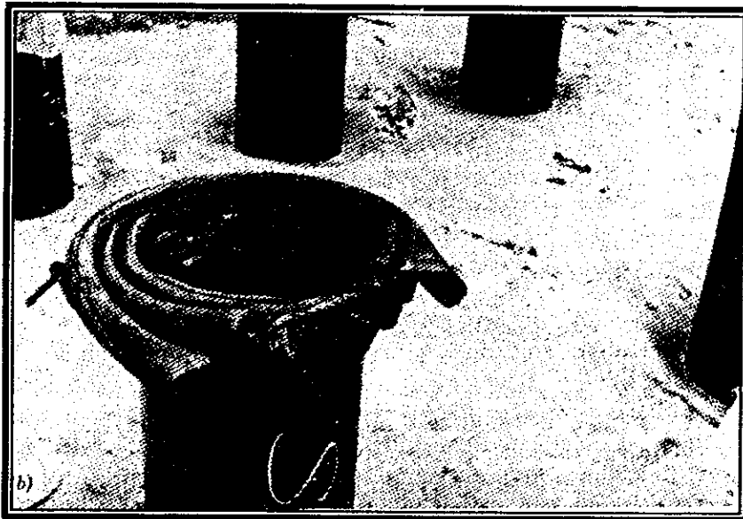
Foto # 5. Pilote tubular de acero, deformado por acción de hincado (3).
