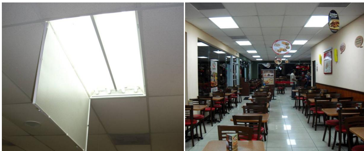
Figura 42. Aspecto de las instalaciones de la Empresa X durante horas de la noche.
