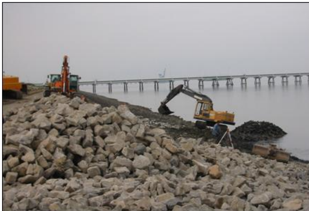
Figura 6: Colocación de riprap por medio de excavadoras hidráulicas
