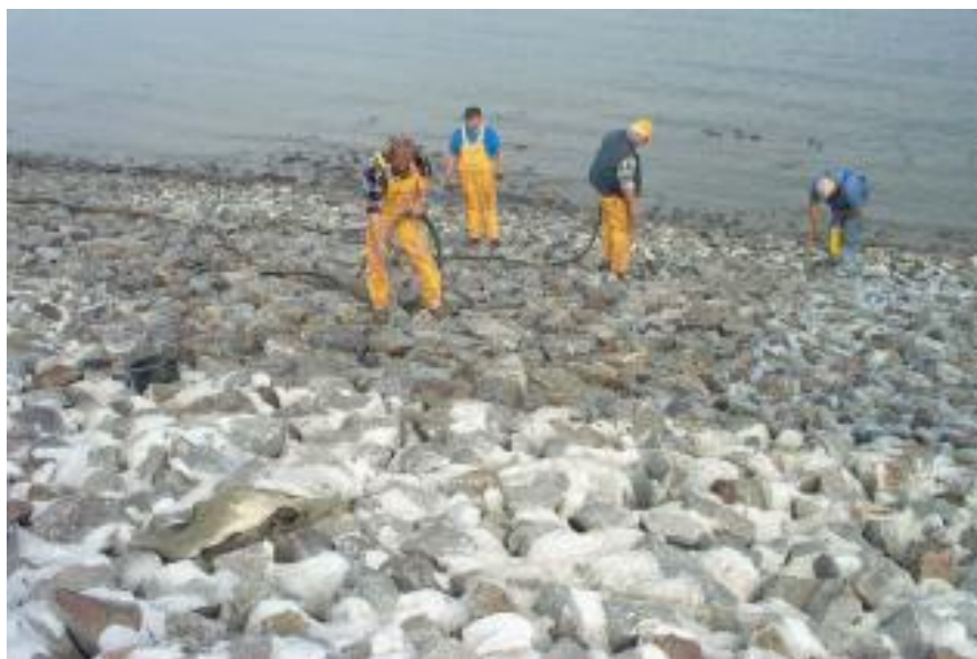
Figura 7: Riprap colocado a mano
