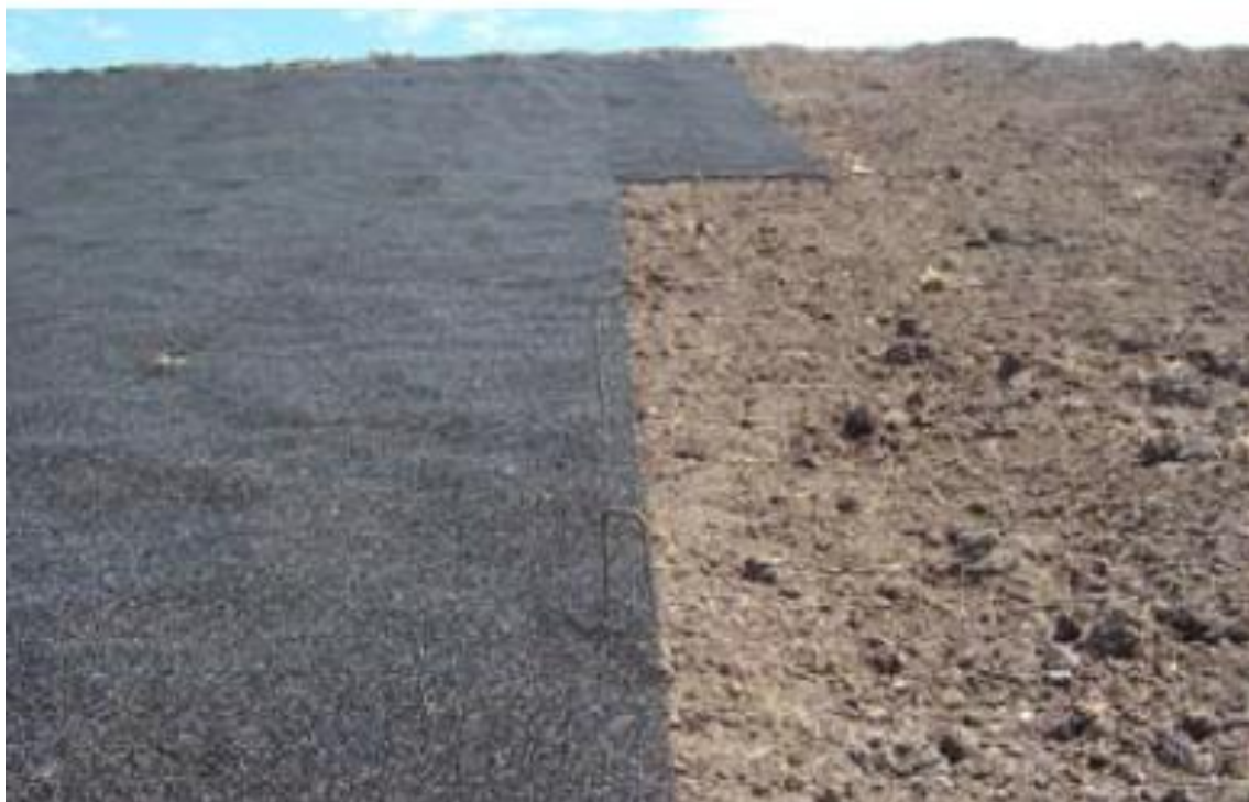
Figura 30: Preparación y colocación de los mantos
