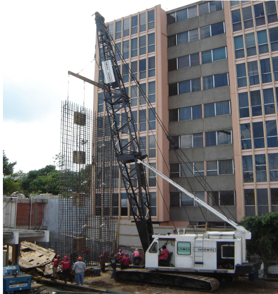
Figura 20: Grúa sobre orugas de alta capacidad
