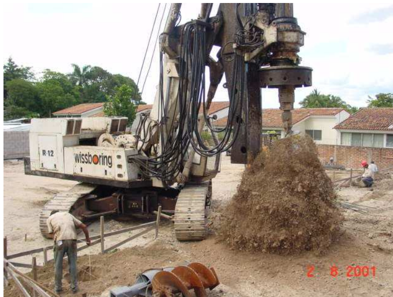
Figura 22: Perforadora hidráulica para perforar pilotes de hasta 1,500mm
