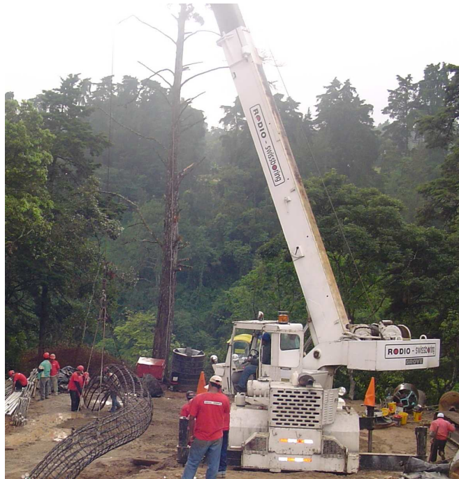
Figura 19: Grúa sobre ruedas de capacidad media
