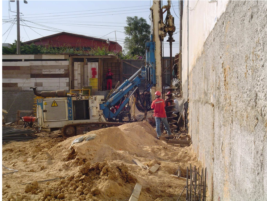
Figura 21 : Perforadora hidráulica para perforar pilotes hasta de 500mm.
