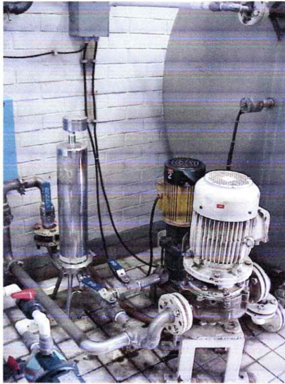
3.7 Vista del conjunto de lámpara ultravioleta, filtro y bomba:
