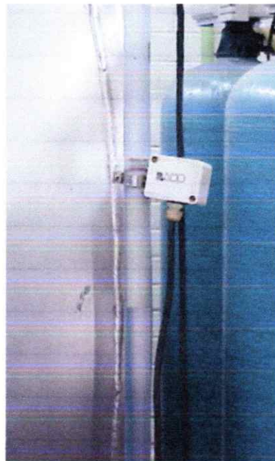
3.5 Medidor de nivel electrónico:
