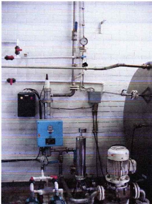
3.7 Vista del conjunto de lámpara ultravioleta, filtro y bomba:
