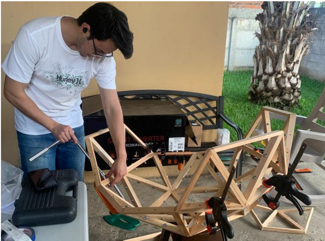
Figura 120: Ensamble de domo geodésico - triángulos esféricos
