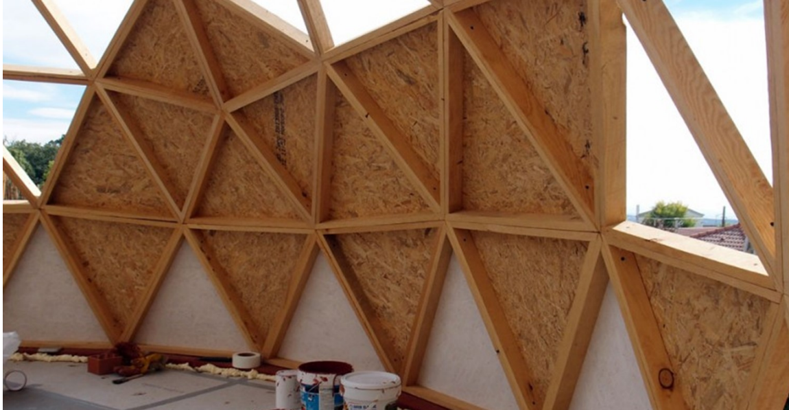
Figura 102: Domo geodésico con placas de madera para superficie exterior
