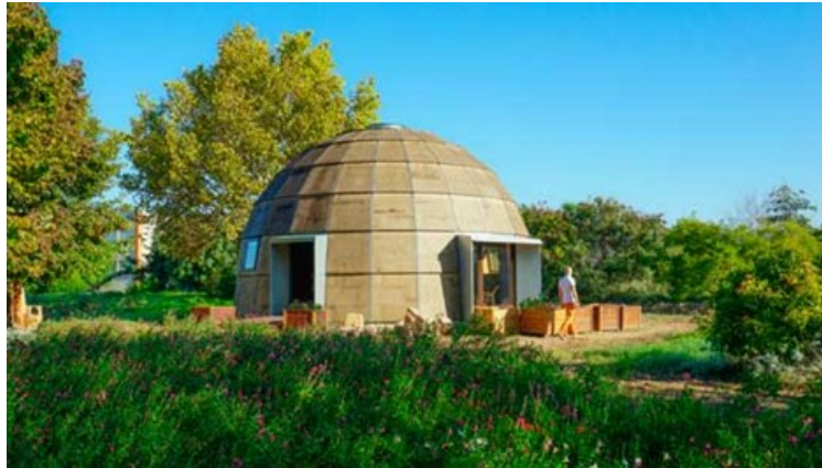
Figura 18: Domo formado por estructura en forma de arcos y planchas cuadradas
