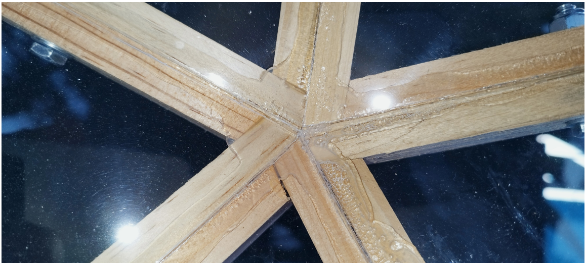
Figura 97: Unión de 6 paneles de plástico diferentes en un vértice
