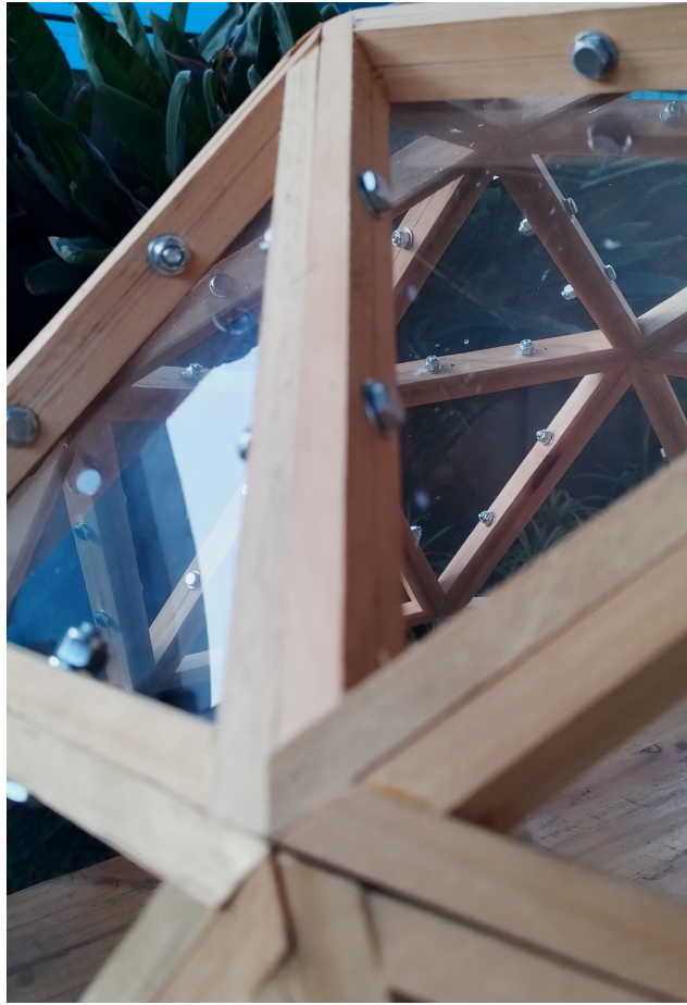
Figura 96: Paneles colocados en la parte interna del domo
