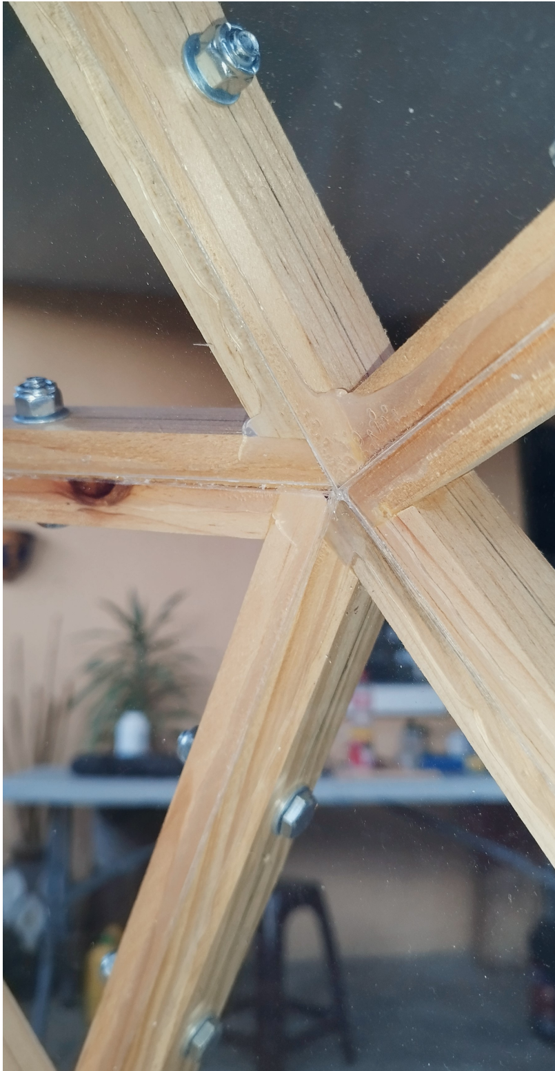
Figura 98: Ensamble pernado para la unión de las varas del domo
