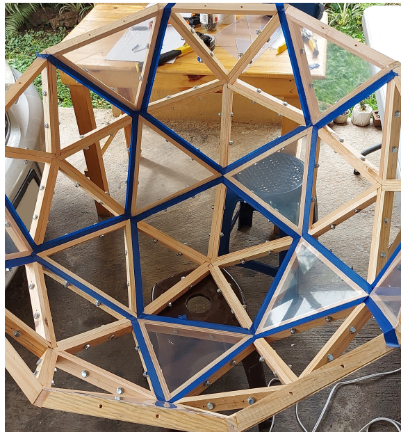
Figura 90: Sellado y unión de paneles transparentes con estructura terminada
