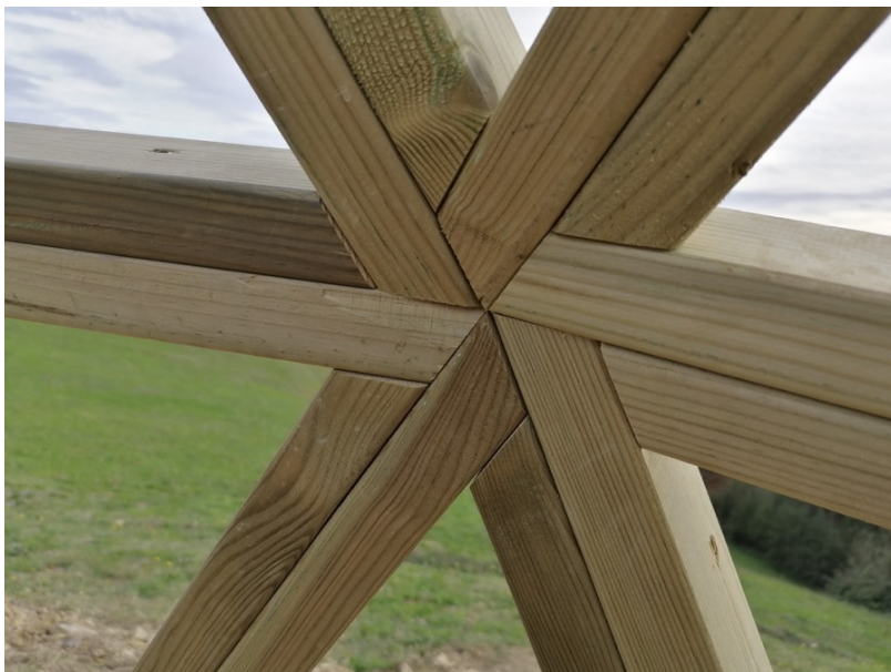
Figura 103: Visualización de terminación de unión de triángulos del domo - vértice de 6 uniones
