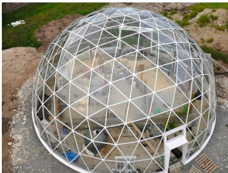
Figura 19: Domo geodésico con estructura metálica y cubierta transparente
