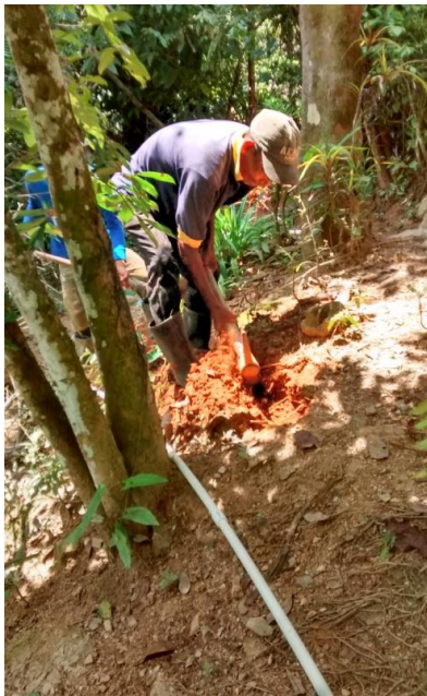
Ilustración 74 - Enterramiento de la tubería
