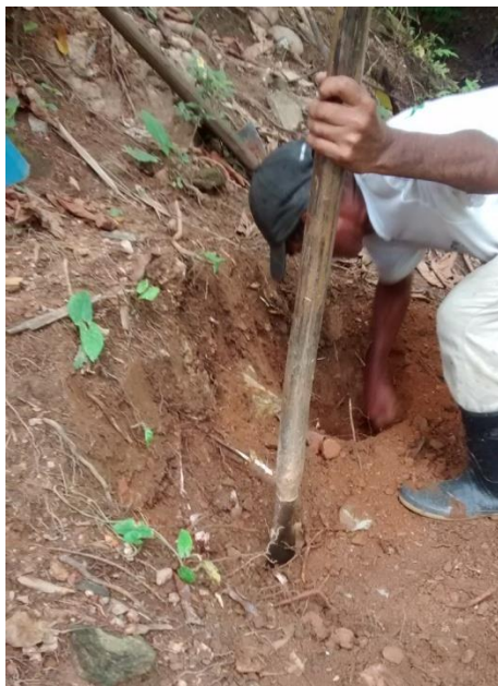
Ilustración 70 - Abertura de agujeros, para enterrar la estructura de metal
