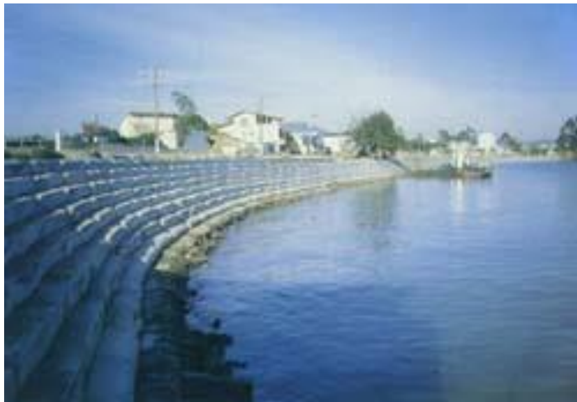
Fotografía 14(protección de canal con geosacos)
