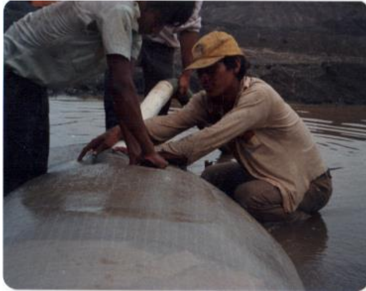
Fotografía 16 (bombeo de mezcla en un geosaco)
