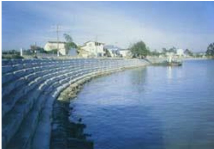
Fotografía 14(protección de canal con geosacos)
