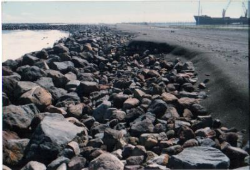
Fotografía 24(enrocamiento utilizado como protección de playa )
