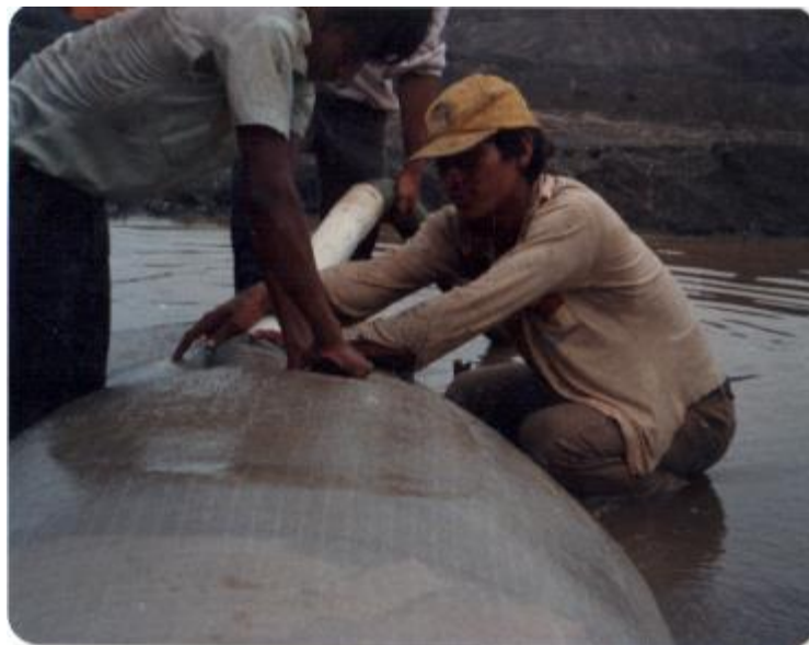
Fotografía 16 (bombeo de mezcla en un geosaco)
