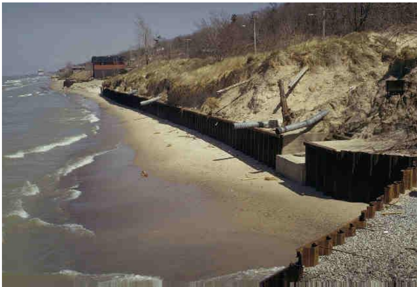
Fotografía 22 (tablaestaqueado como muro de retención)
