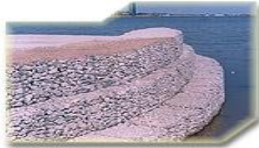
Figura 12 (rompeolas construido con gaviones)
