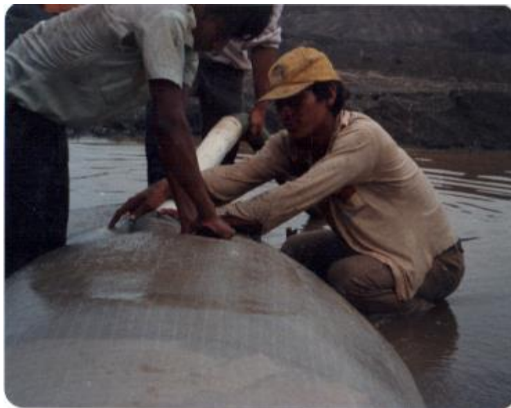
Fotografía 16 (bombeo de mezcla en un geosaco)
