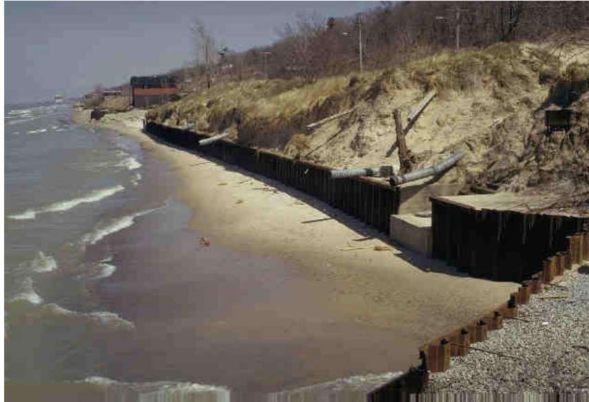
Fotografía 22 (tablaestaqueado como muro de retención)
