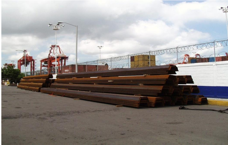
Fotografía 23 (tablaestacas a utilizar en la cimentación del Fuerte de San Juan de Ulúa, México)
