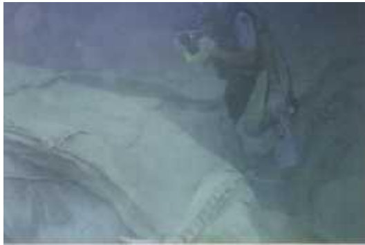
Fotografía 17 (buzo inspecciona estructura de geosaco)
