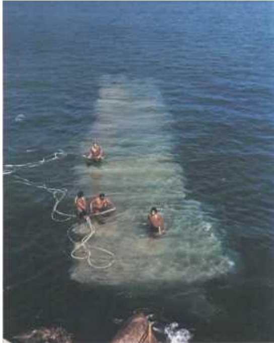
Fotografía 15(geosaco clocado como base de muelle de carga)
