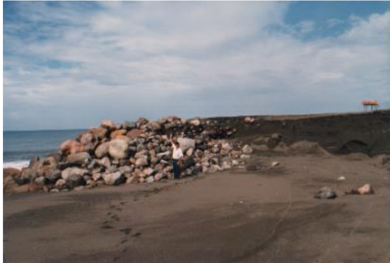
Fotografía 25 (enrocamiento como protección de playa)
