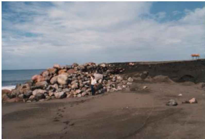
Fotografía 25 (enrocamiento como protección de playa)
