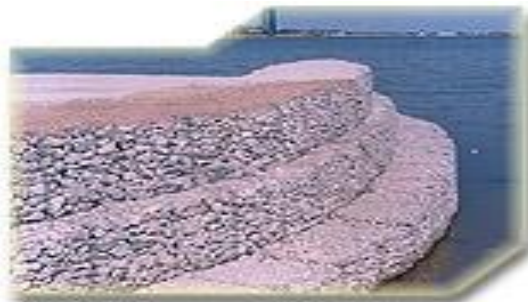
Figura 12 (rompeolas construido con gaviones)
