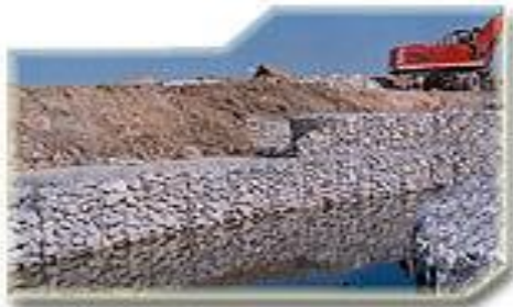
Figura 11 (canal construido con gaviones)
