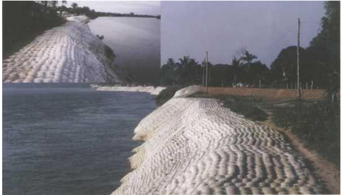
Fotografía 18 (Protección de talud costero con tapete antisocavacion)
