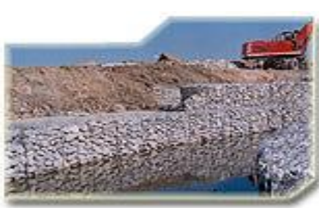
Figura 11 (canal construido con gaviones)
