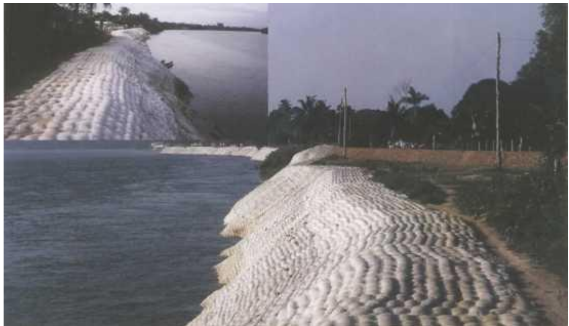
Fotografía 18 (Protección de talud costero con tapete antisocavacion)
