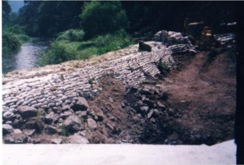
Fotografía 5 (presas y diques)
