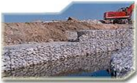
Figura 11 (canal construido con gaviones)
