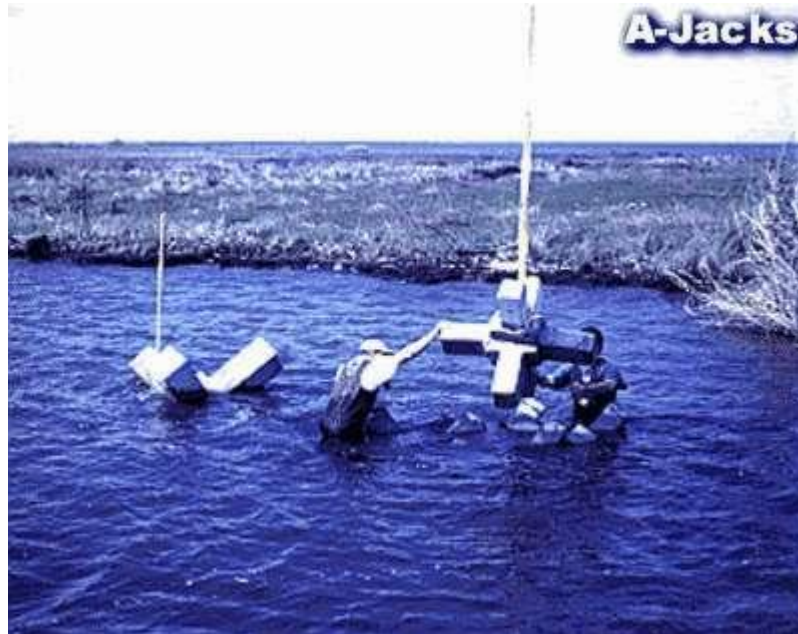
Fotografía 26 (colocación de hexápodos de concreto en canal)
