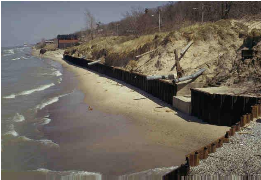
Fotografía 22 (tablaestaqueado como muro de retención)
