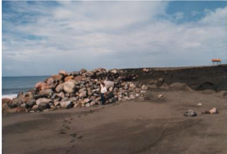
Fotografía 25 (enrocamiento como protección de playa)
