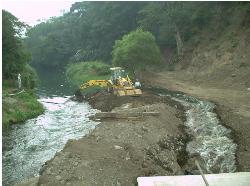
Fotografía 4 (remoción de material)
