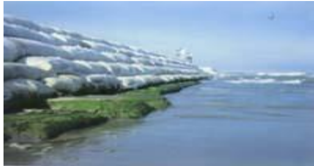
Fotografía 13 (rompeolas construido con geosacos)
