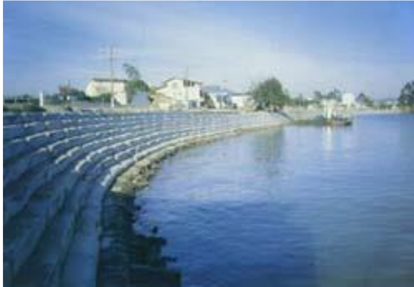
Fotografía 14(protección de canal con geosacos)
