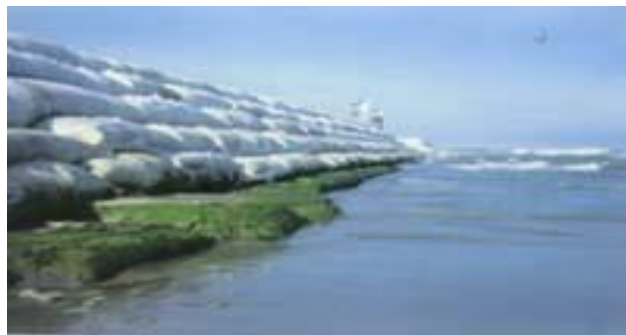
Fotografía 13 (rompeolas construido con geosacos)
