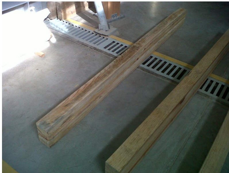
Vigas de madera laminada
