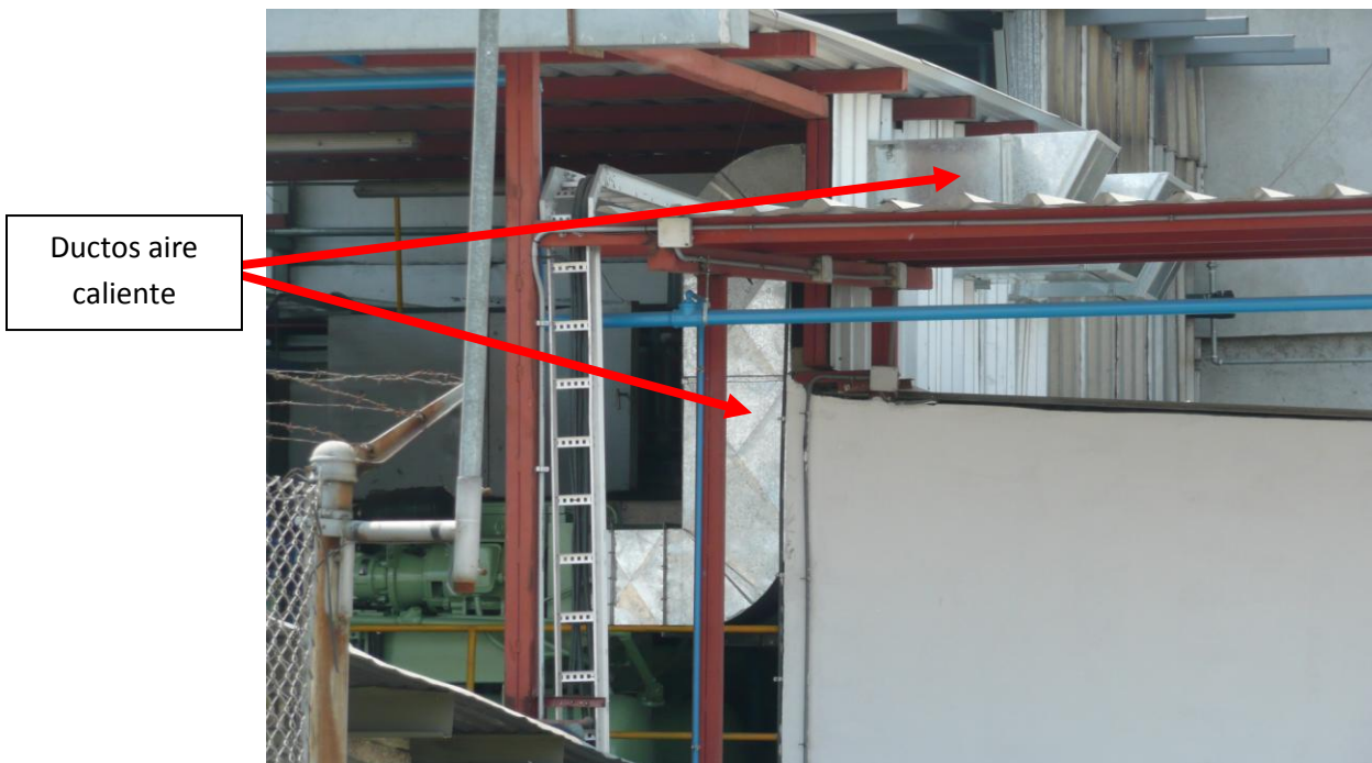
Foto # 6 Instalación de los compresores sistema mejorado – ductos para eliminación de aire caliente.
