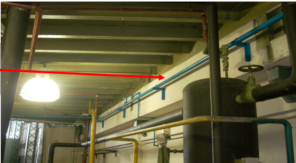
Foto # 8 Instalación de red de aire comprimido sistema mejorado
