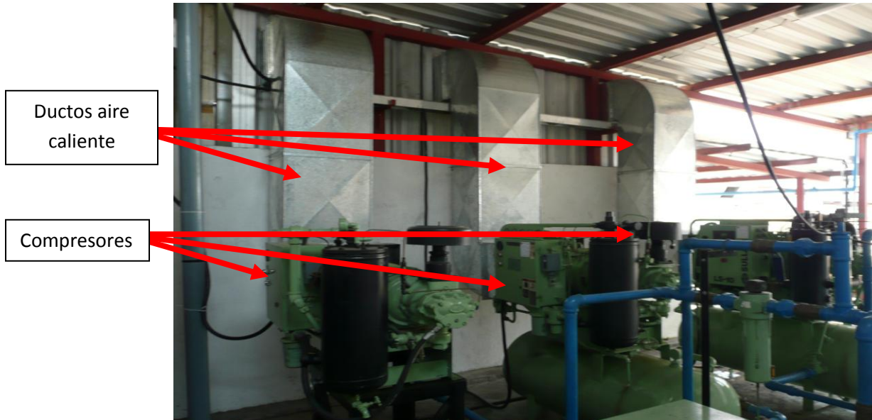
Foto # 5 Instalación de los compresores sistema mejorado
