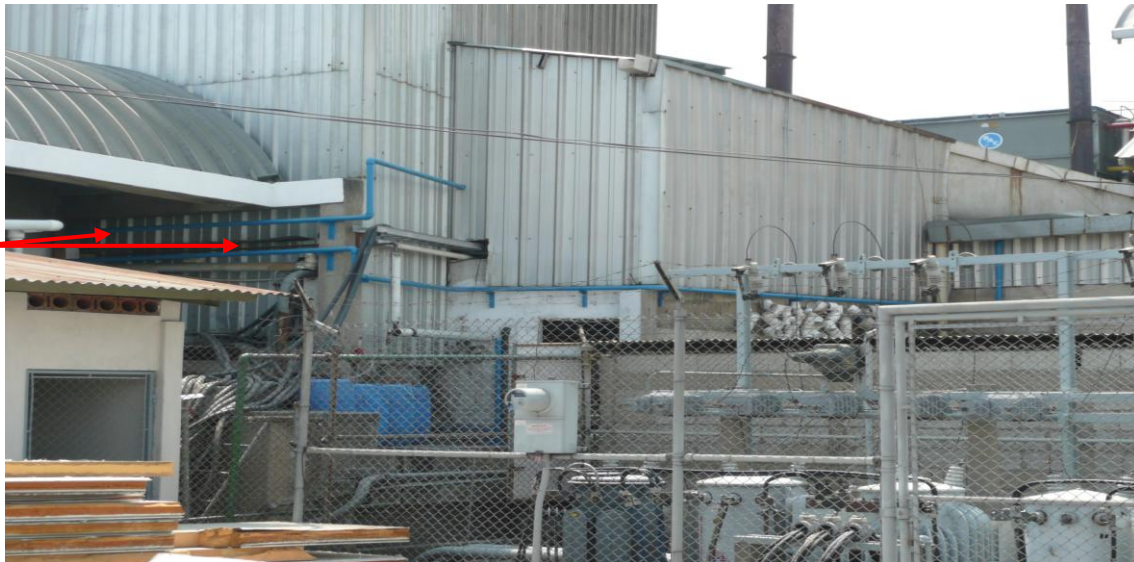
Foto # 7 Instalación de red de aire comprimido sistema mejorado
