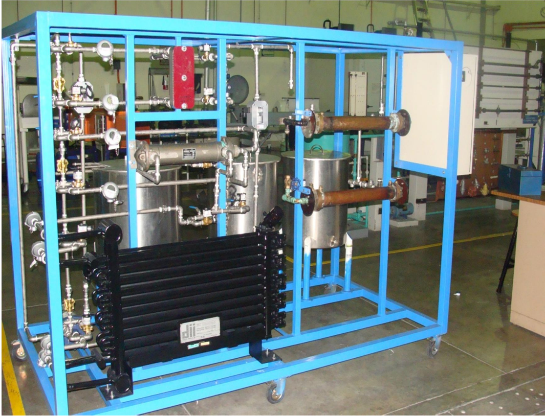
Figura No. 20 Estructura y equipos
