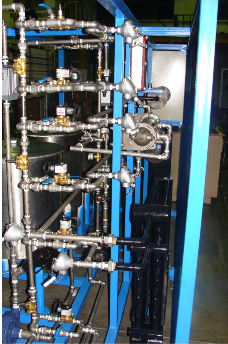
Figura No. 21 Tubería y accesorios instalados
