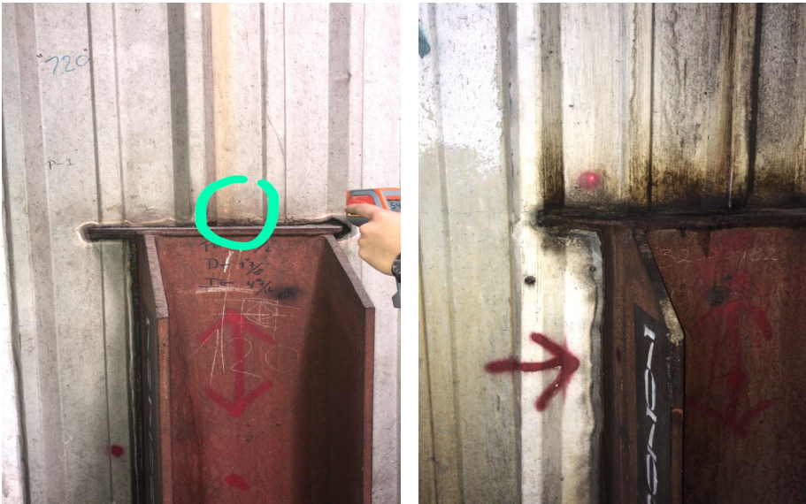
Figura 102 Puntos de medición temperaturas exteriores en la calandria evaporador primer efecto 1.
