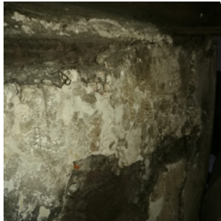
Figura 158. Recubrimiento térmico actual de fibra cerámica en los evaporadores.
