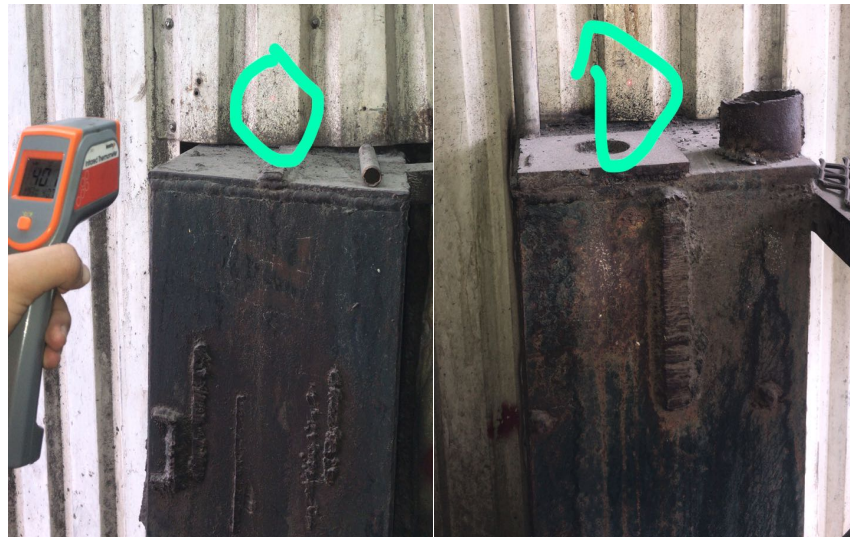
Figura 110. Puntos de medición temperaturas exteriores en la calandria evaporador segundo efecto 1.
