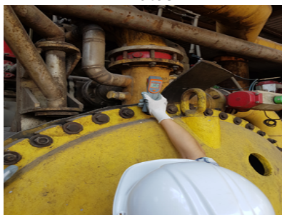
Figura 176. Medición entrada de jugo en el intercambiador 9 de concha y tubo de tiempo 13.67 minutos.
