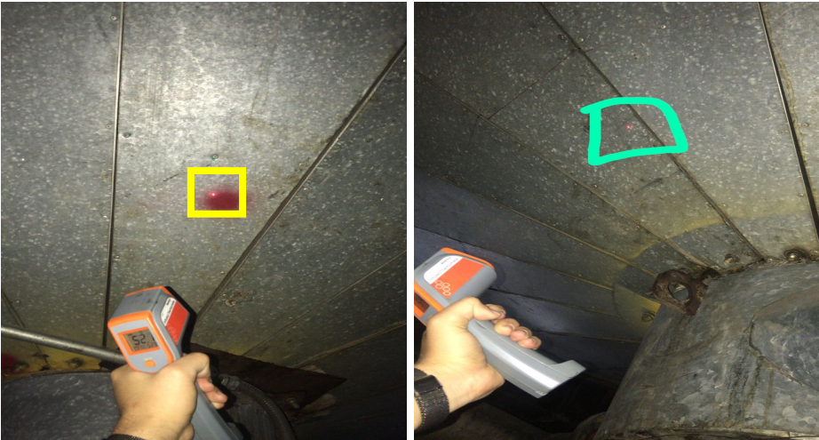
Figura 106. Puntos de medición temperaturas exteriores en la calandria evaporador primer efecto 3.
