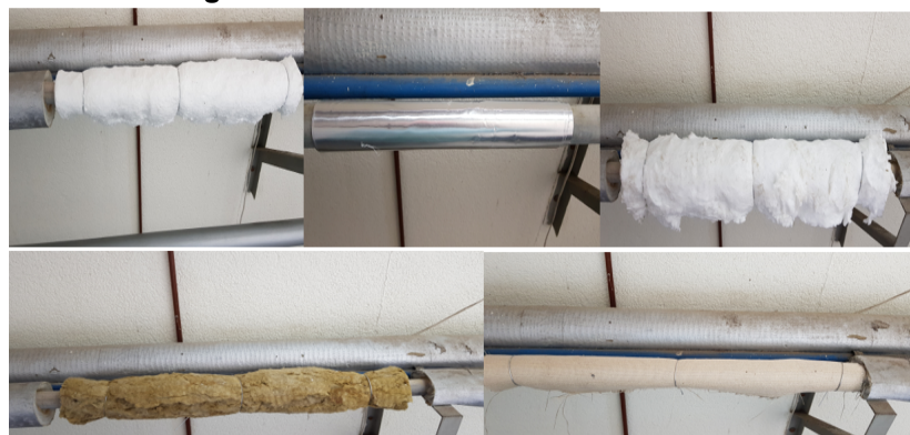
Figura 61. Materiales montados en tubería.
