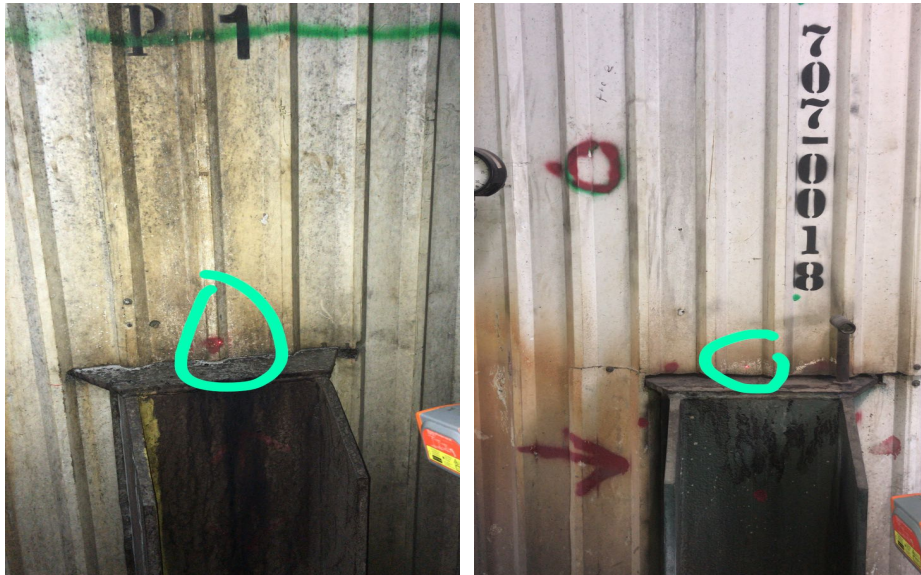
Figura 104. Puntos de medición temperaturas exteriores en la calandria evaporador primer efecto 2.
