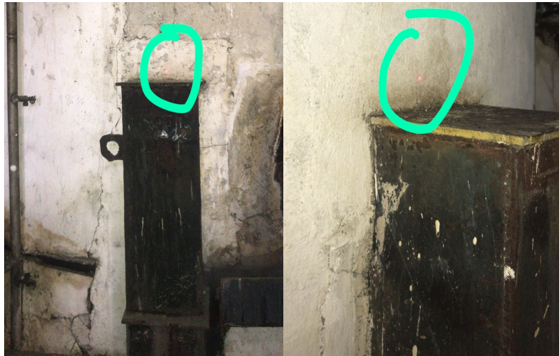
Figura 112. Puntos de medición temperaturas exteriores en la calandria evaporador segundo efecto 2.
