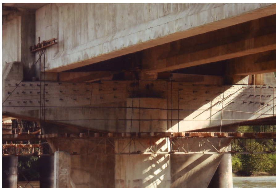
Figura No. 32: detalle de la instalación de pasadores para la armadura donde se instalarían los ductos con los cables
