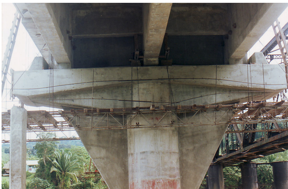
Figura No. 43: viga de apoyo reforzado con postensado externo
