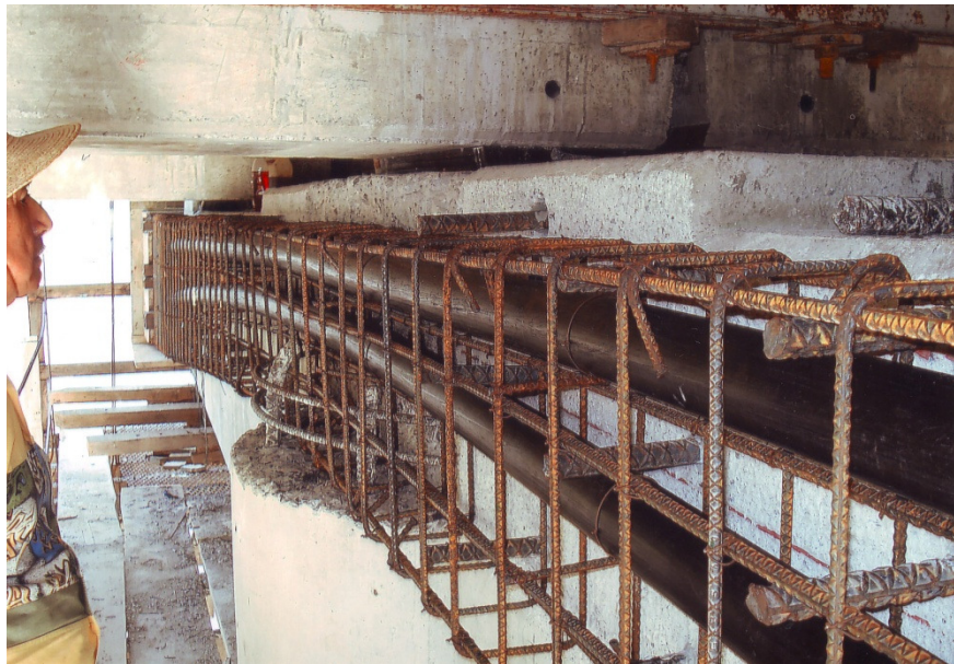
Figura No. 36: panorámica de los ductos con su parábola dentro de la armadura
