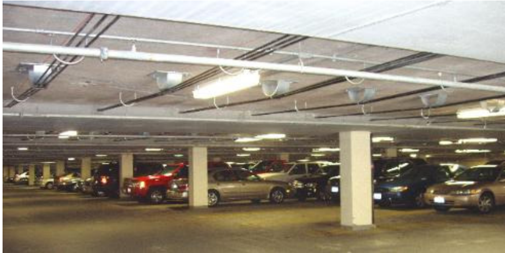
Figura No. 20: postensado externo para losas de parqueos
