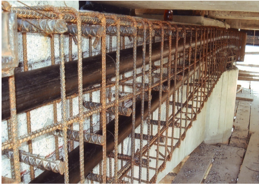
Figura No. 35: panorámica de los ductos con su parábola dentro de la armadura
