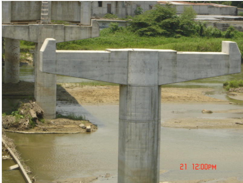
Figura No. 27: panorámica de la pila intermedia previo a aplicársele postensado externo
