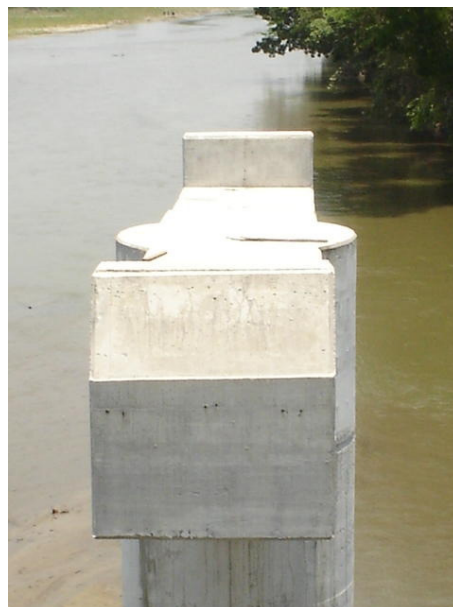
Fotografía No. 28: elevación del martillo
