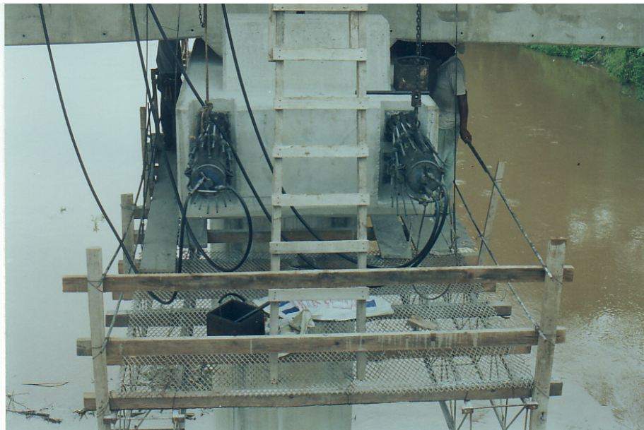
Figura No. 40: tensado simultáneo
