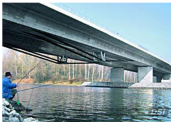
Figura No. 25: postensado externo para el reforzamiento de vigas de concreto
