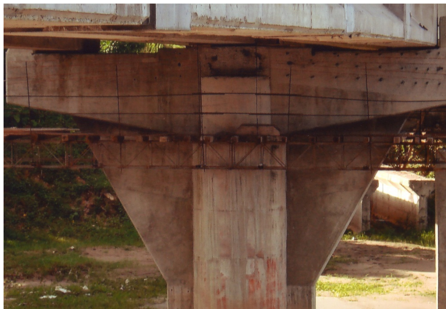
Figura No. 32: detalle de la instalación de pasadores para la armadura donde se instalarían los ductos con los cables
