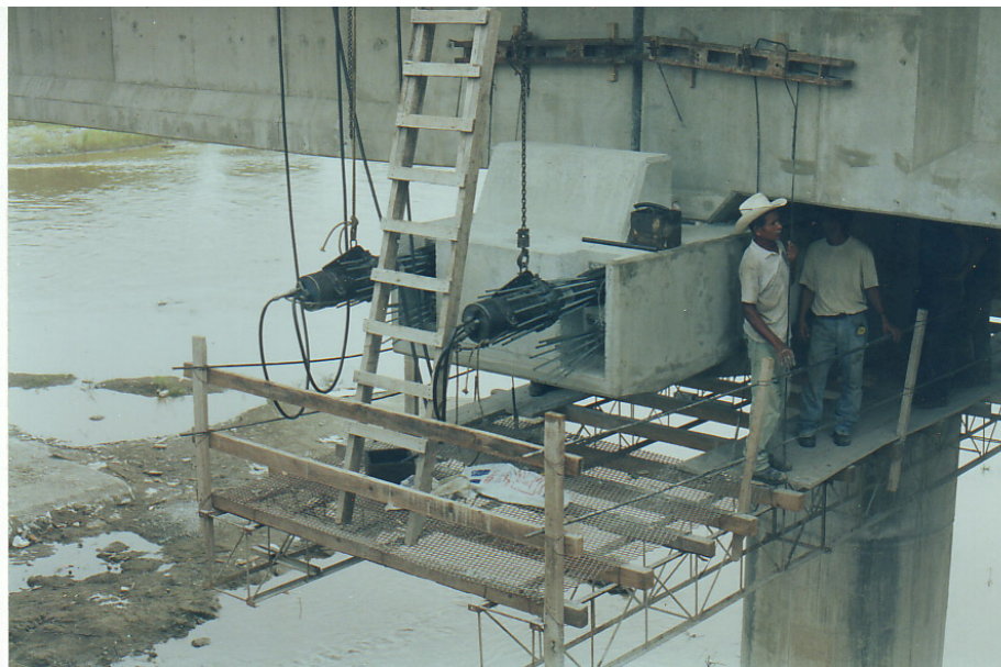
Figura No. 40: tensado simultáneo
