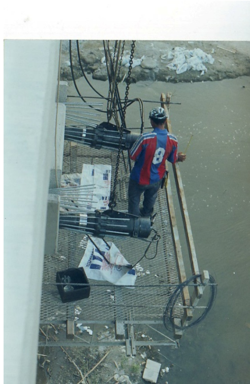
Figura No. 41: aplicación de fuerza simultánea en ambos anclajes
