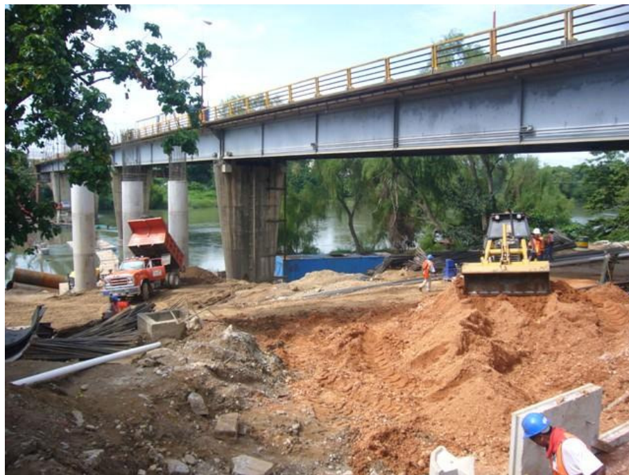
Figura No. 23: postensado externo para el reforzamiento de vigas de metal
