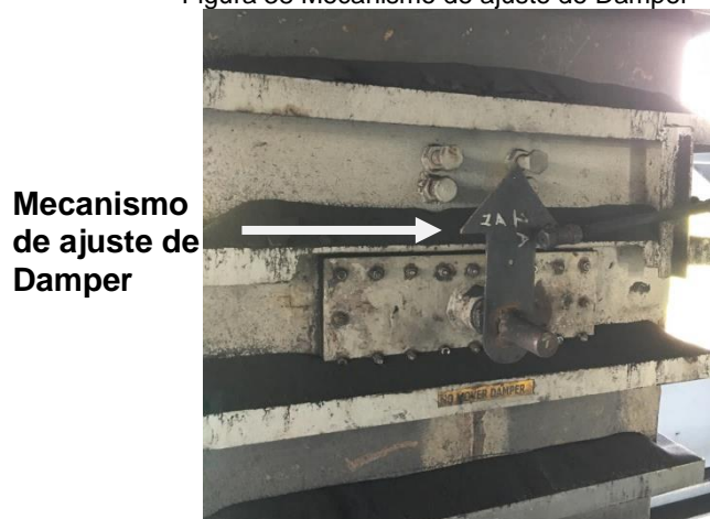
Figura 38 Mecanismo de ajuste de Damper
