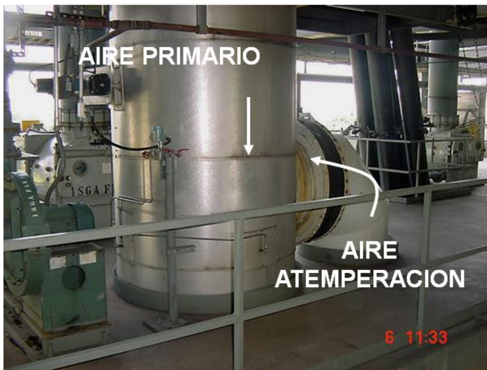
Figura 18 Sistema de aire primario y atemperación
