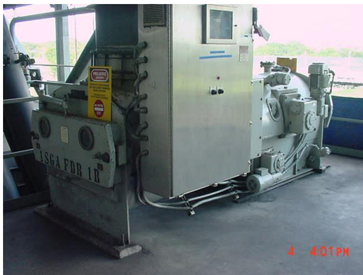
Figura 16 Alimentador gravimétrico
