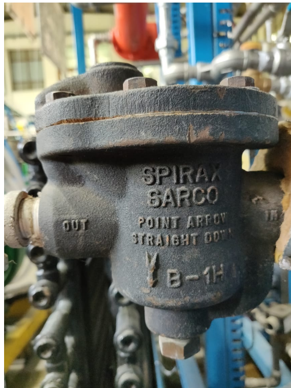
Figura 38: Montaje de las trampas de vapor.
