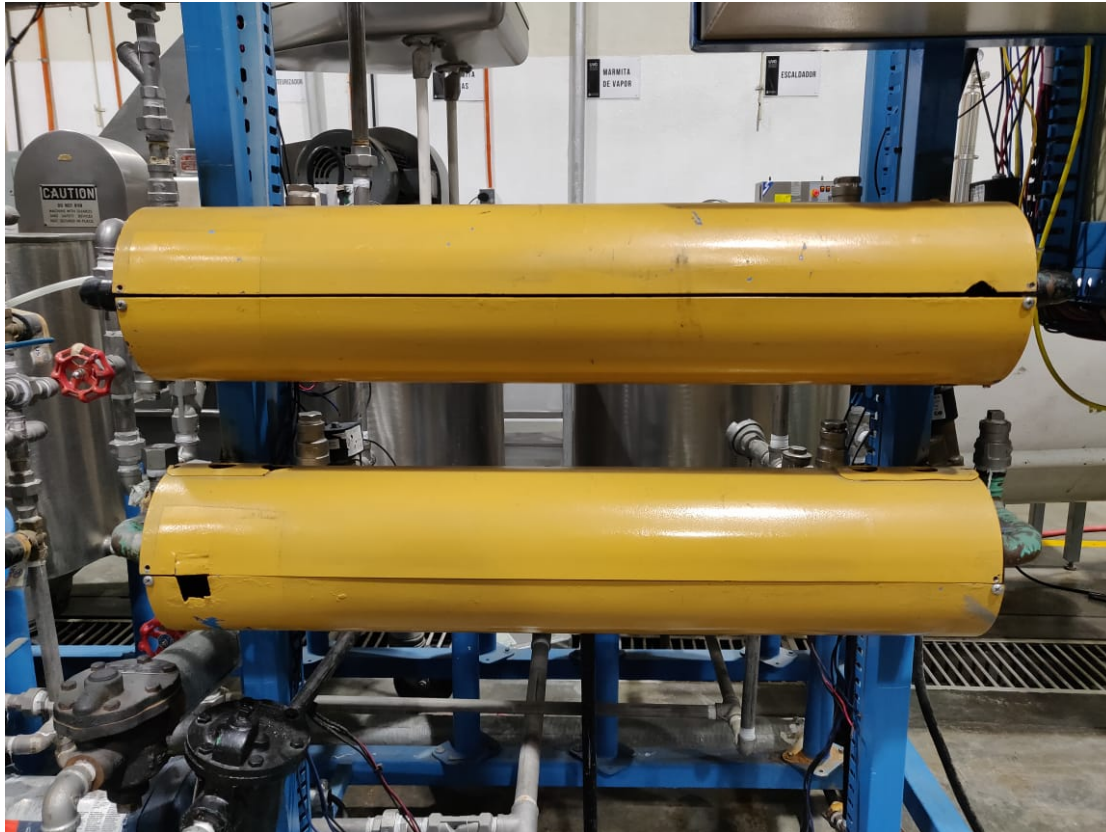
Figura 41: Montaje de los dos condensadores de vapor instalados.
