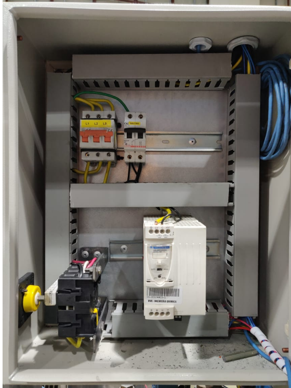
Figura 44: Montaje del panel nuevo con sus respectivos dispositivos instalados (Interior).
