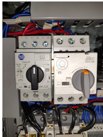
Figura 53: Instalación de los dos guardamotores.
