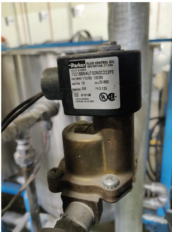
Figura 40: Montaje de las válvulas de vapor marca Parker.
