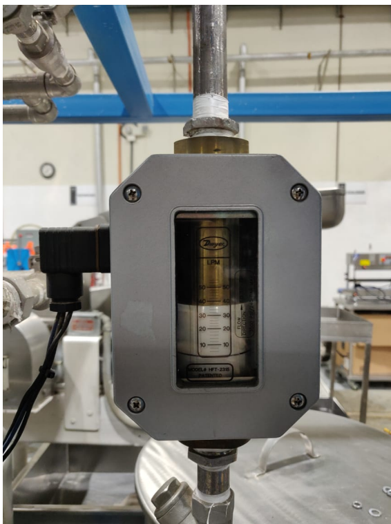
Figura 39: Montaje de los medidores de flujo variable.
