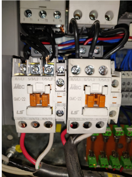
Figura 54: Instalación de los contactores.
