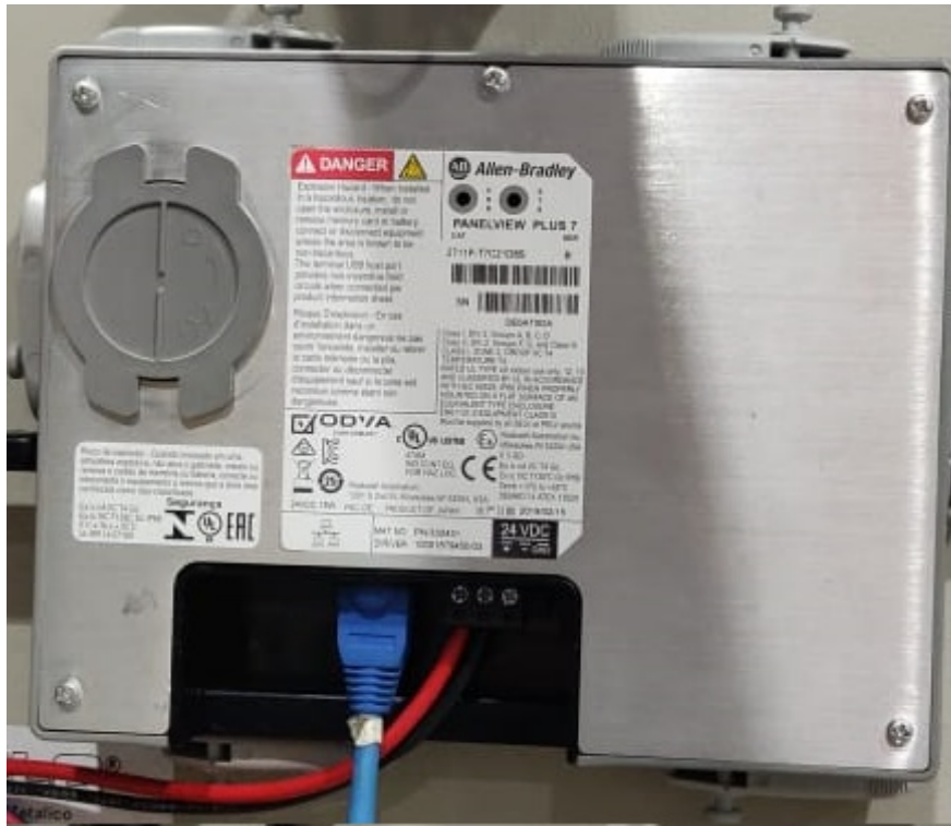
Figura 58: Instalación de la pantalla HMI Touch (interior).
