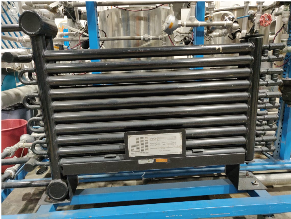
Figura 36: Montaje del intercambiador de calor de tubos concéntricos.
