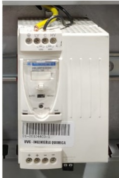
Figura 50: Instalación de la fuente de alimentación.
