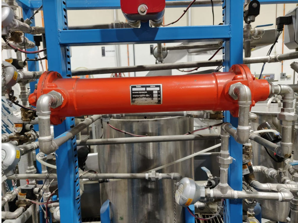
Figura 35: Montaje del intercambiador de calor de concha y tubos.
