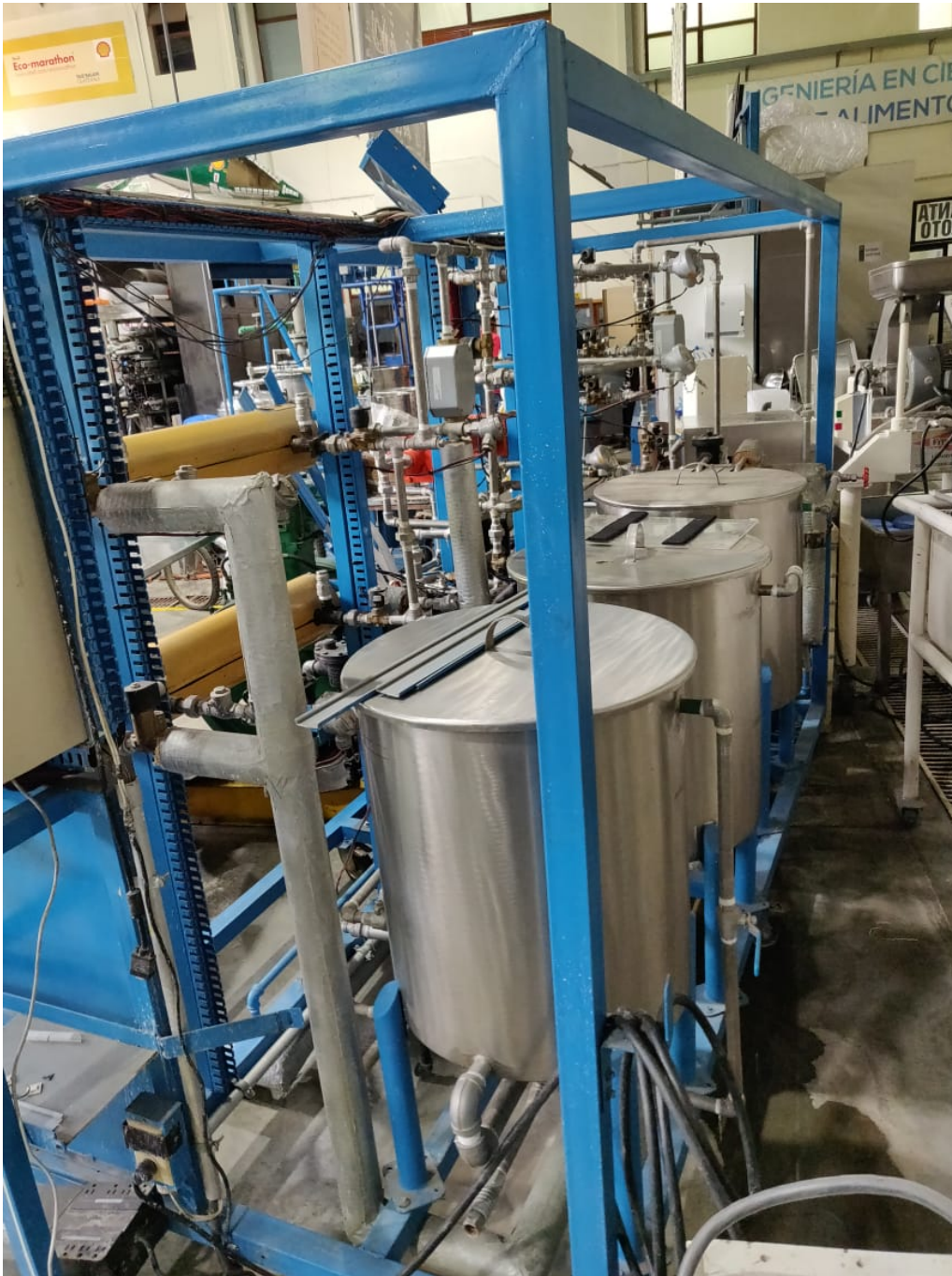
Figura 34: Montaje de los tanques.
