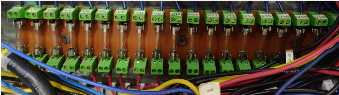
Figura 56: Instalación de las borneras de protección con fusibles.
