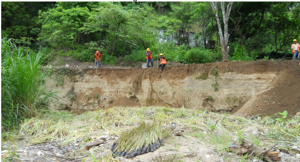
Imagen 76 Perfilado del talud
