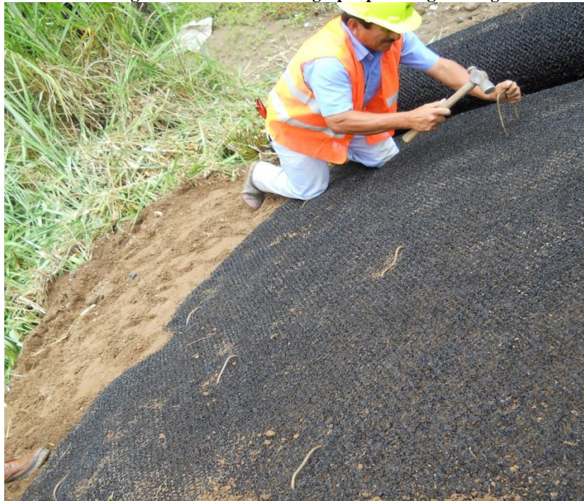
Imagen 58 Colocación de las grapas para asegurar la geomanta
