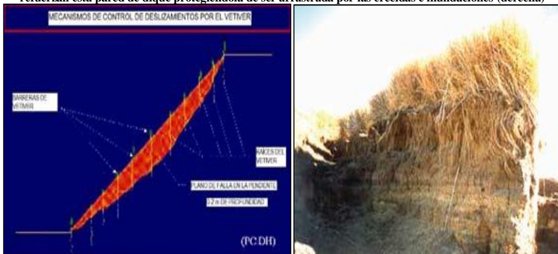
Imagen 5 Principios de Estabilización de pendientes con el Vetiver (izquierda); las raíces de Vetiver refuerzan esta pared de dique protegiéndola de ser arrastrada por las crecidas e inundaciones (derecha)
