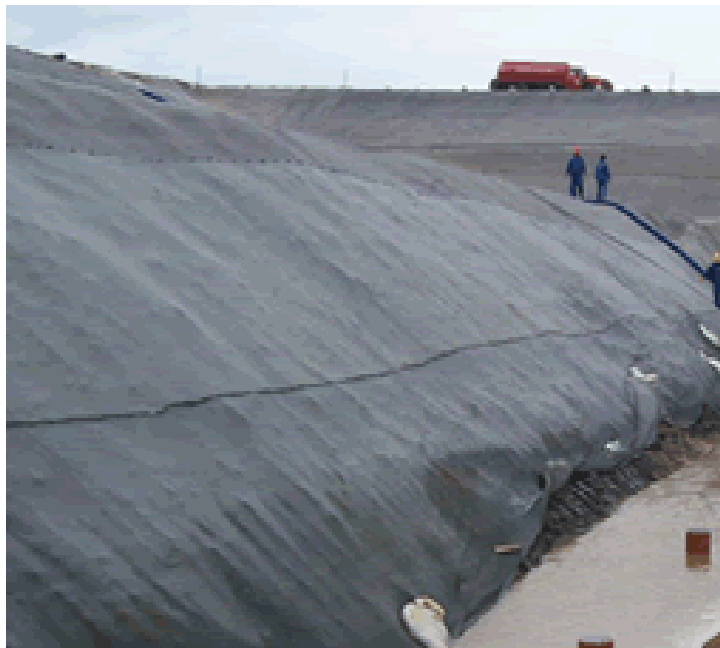
Imagen 10 Utilización de geotextil para el control de erosión
