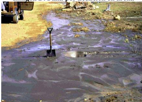
Imagen 24 Falla por licuación en arena
