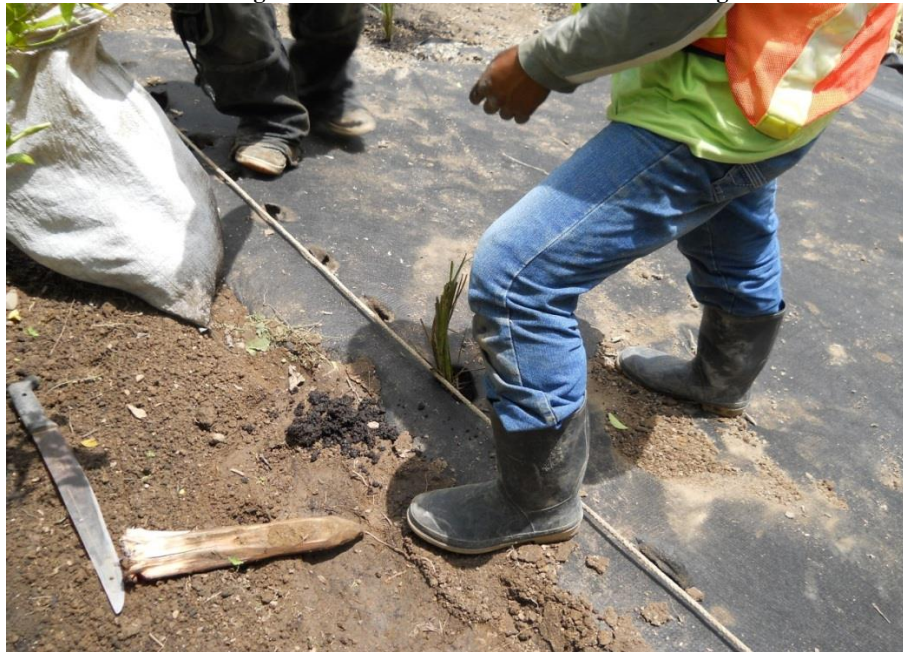
Imagen 74 Sembrado del Vetiver combinado con geotextil
