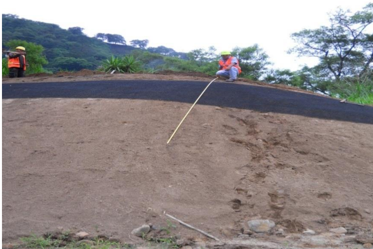
Imagen 56 Mediciones previas a la instalación de la geomanta
