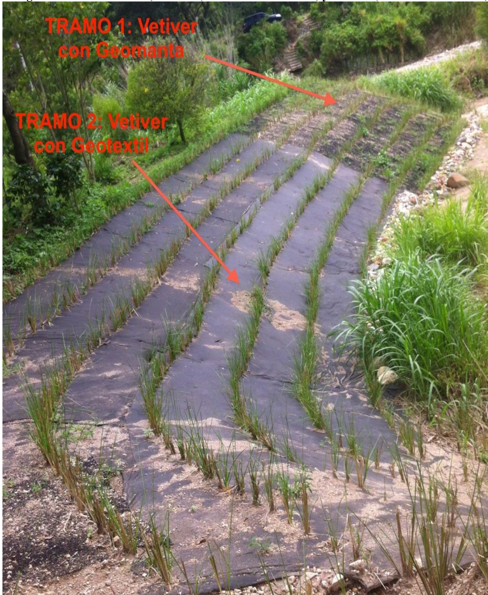
Imagen 35 División del talud, tramo 1 (Vetiver con Geomanta) y tramo 2 (Vetiver con Geotextil)
