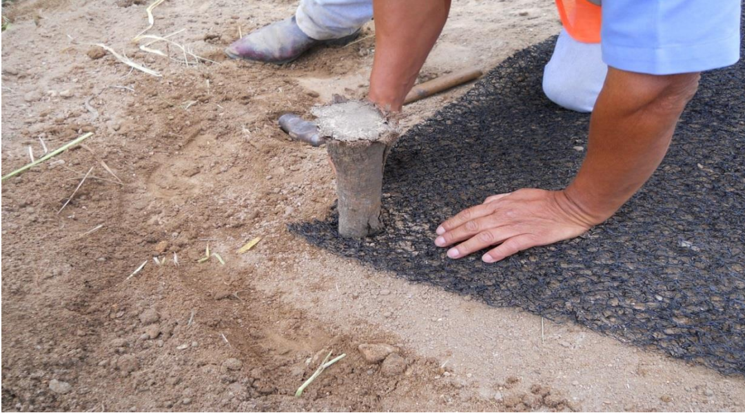
Imagen 61 Realización de hoyos para la siembra del talud
