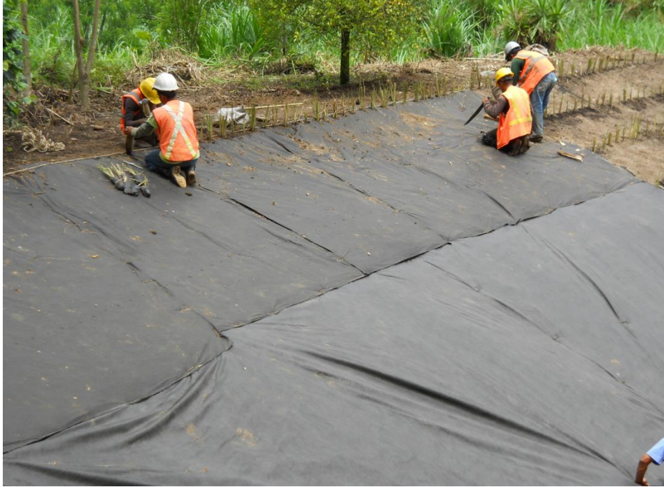
Imagen 71 Geotextil instalado en el talud
