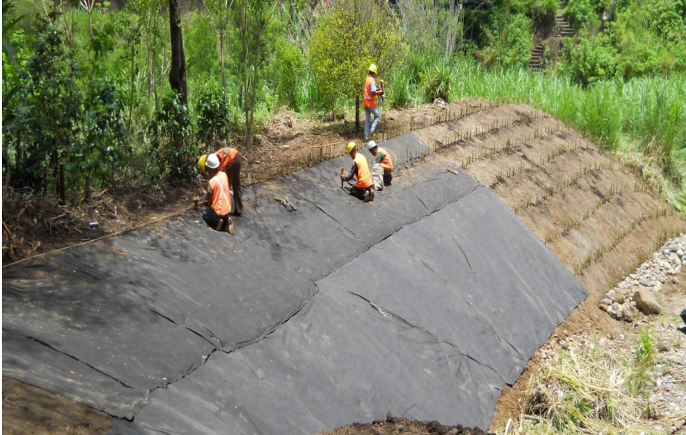
Imagen 75 Talud de Vetiver en combinación con geotextil
