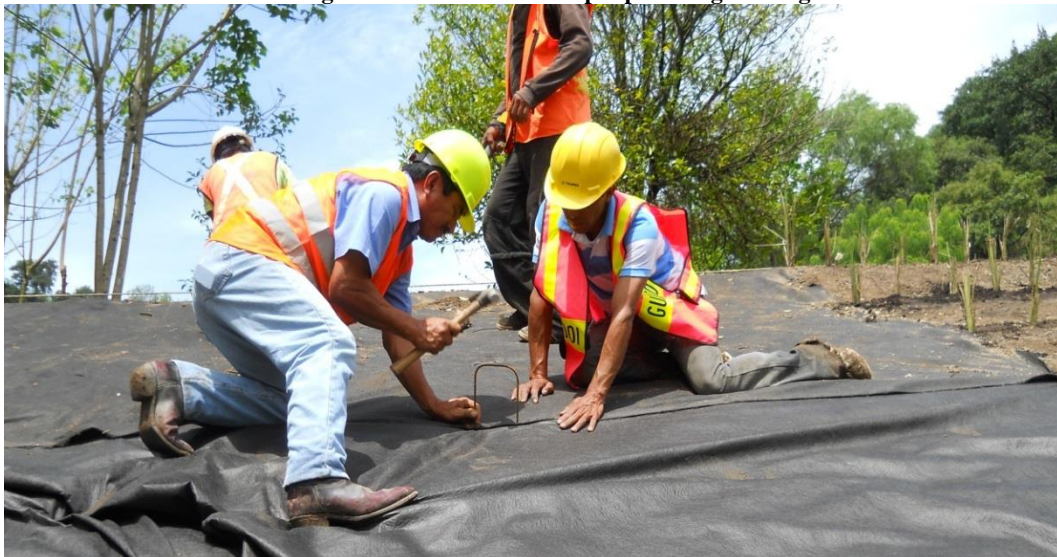
Imagen 70 Colocación de Grapas para asegurar el geotextil
