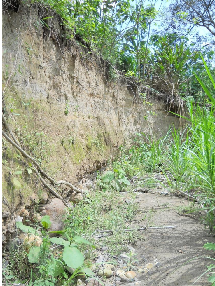
Imagen 34 Talud en estado inicial, vista este
