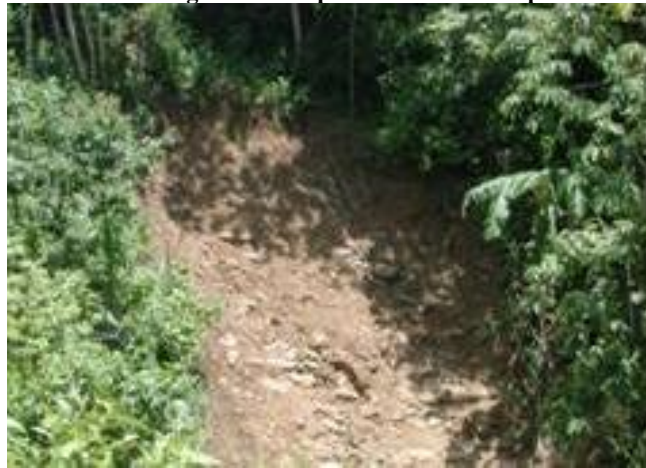
Imagen 21 Falla por deslizamiento superficial
