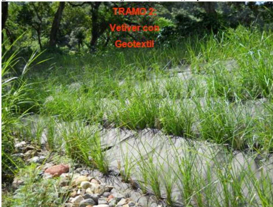
Imagen 40 Sistema Vetiver combinado con geotextil (13/08/2012), después de varias lluvias
