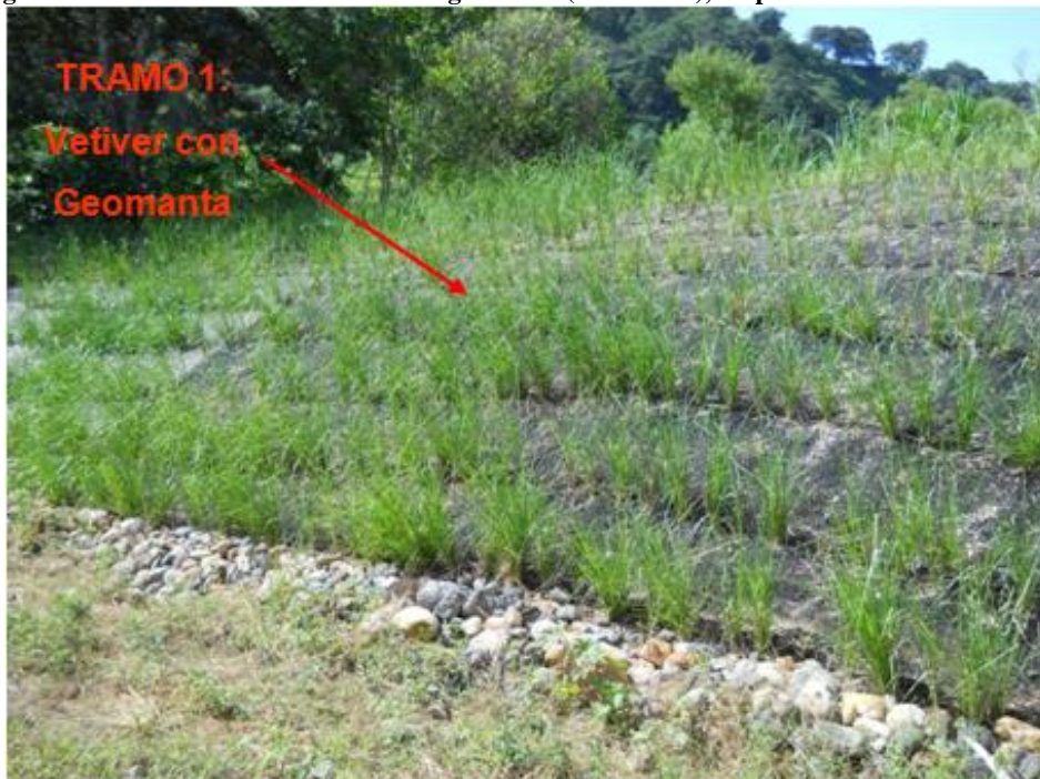
Imagen 39 Sistema Vetiver combinado con geomanta (13/08/2012), después de varias lluvias
