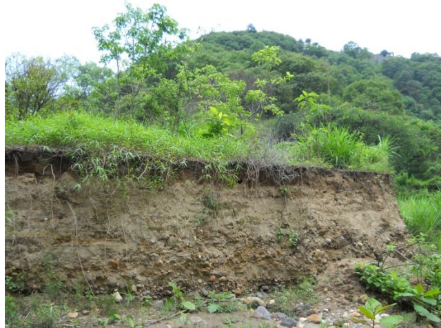
Imagen 33 Talud en estado inicial, vista oeste
