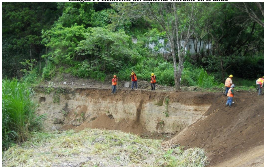
Imagen 50 Remoción del material sobrante en el talud
