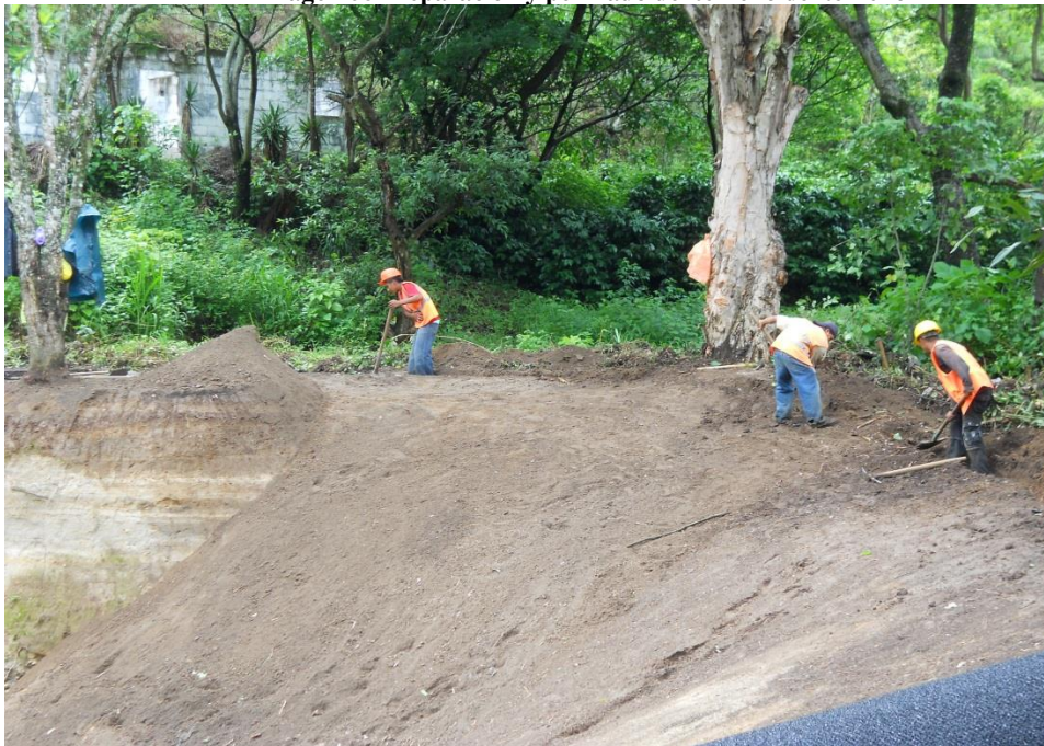
Imagen 66 Preparación y perfilado del terreno del terreno
