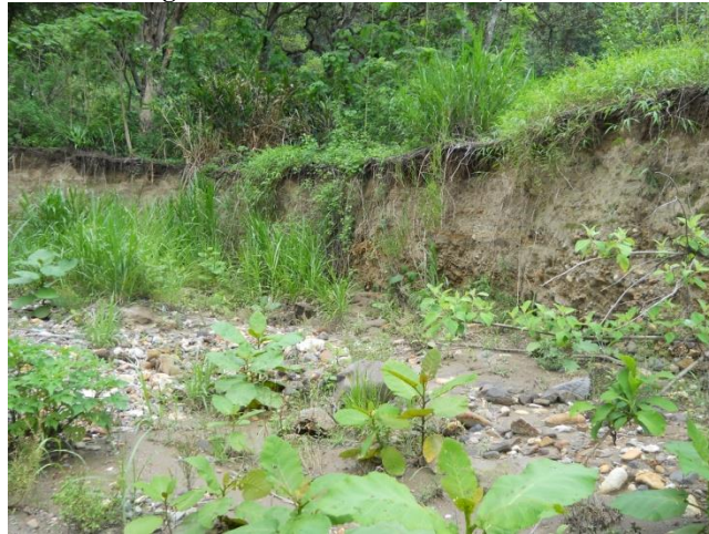
Imagen 32 Talud en estado inicial, vista sur
