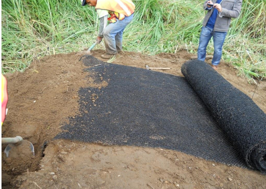
Imagen 57 Instalación de la Geomanta
