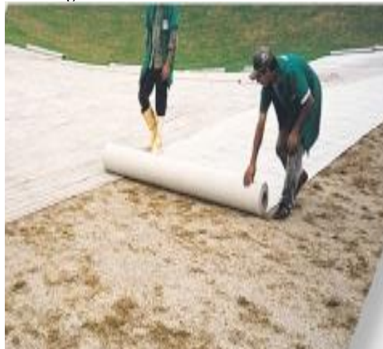
Imagen 9 Utilización de Biomanta en Taludes
