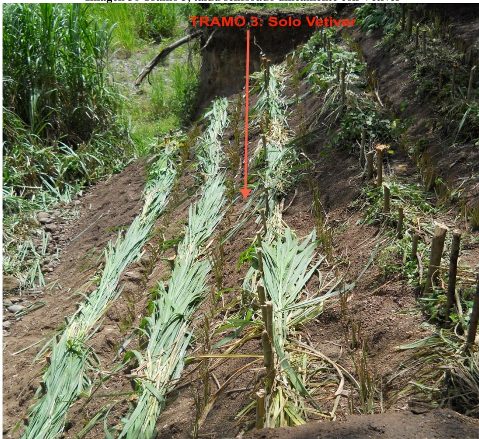
Imagen 36 Tramo 3, talud sembrado únicamente con Vetiver
