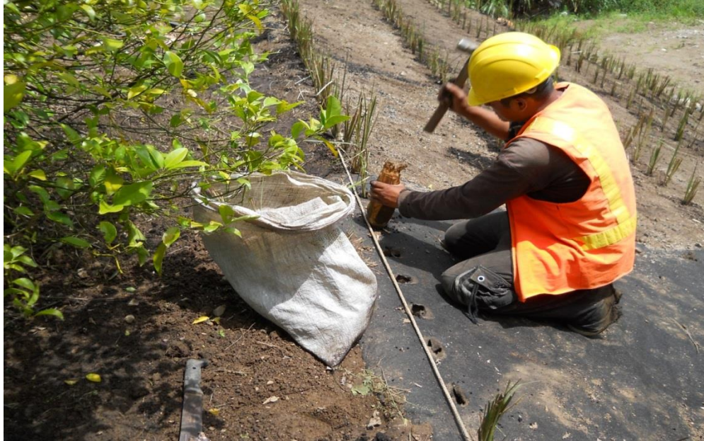
Imagen 73 Ahoyado del tramo de Vetiver combinado con geotextil
