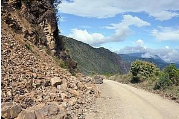
Imagen 22 Falla por deslizamiento de arcilla sobre superficie de falla existentes
