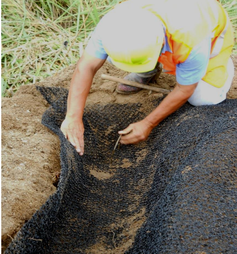
Imagen 55 Colocación de grapas en la zanja
