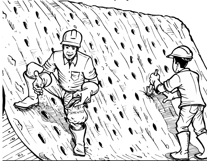
Figura 129 Realización de hoyos para la siembra
