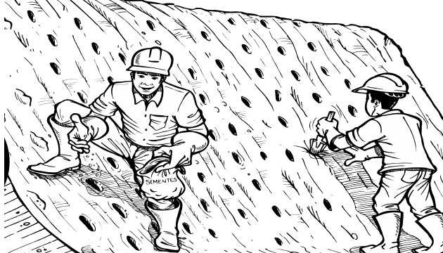
Figura 135 Realización de hoyos para la siembra
