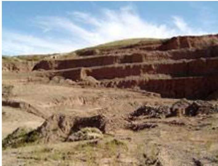
Imagen 25 Utilización de bermas en un talud
