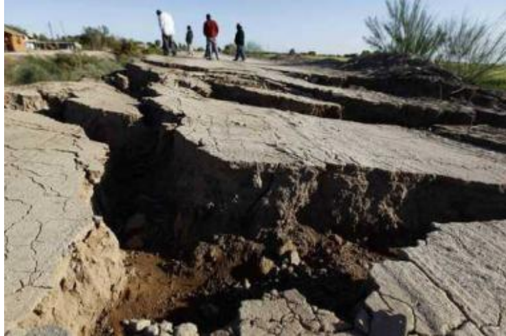
Imagen 17 Agrietamiento después de un sismo en Mejjicali, Baja California
