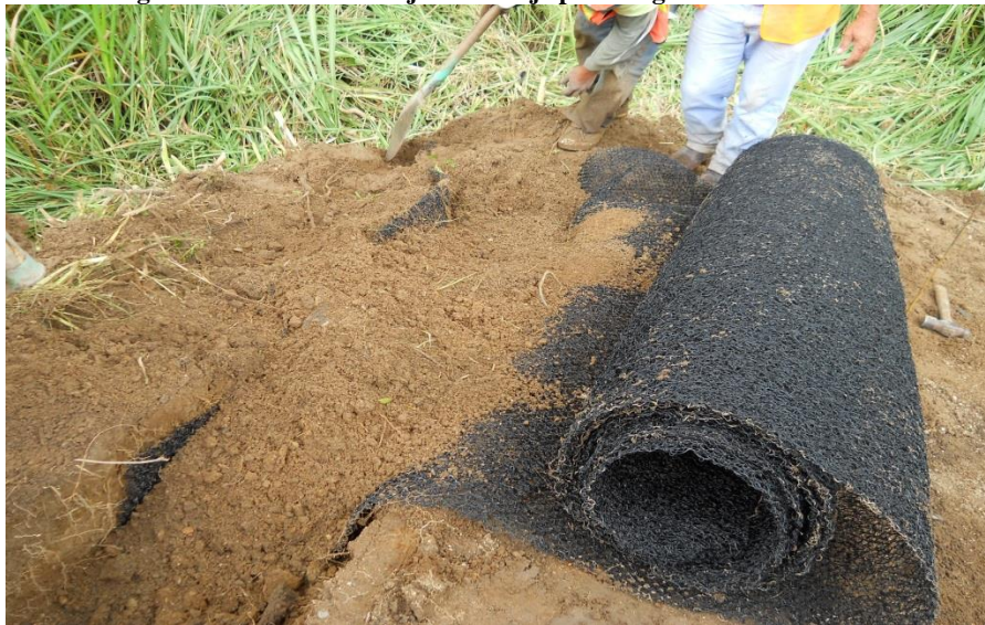
Imagen 54 Relleno de la zanja de anclaje para la geomanta en la corona del talud
