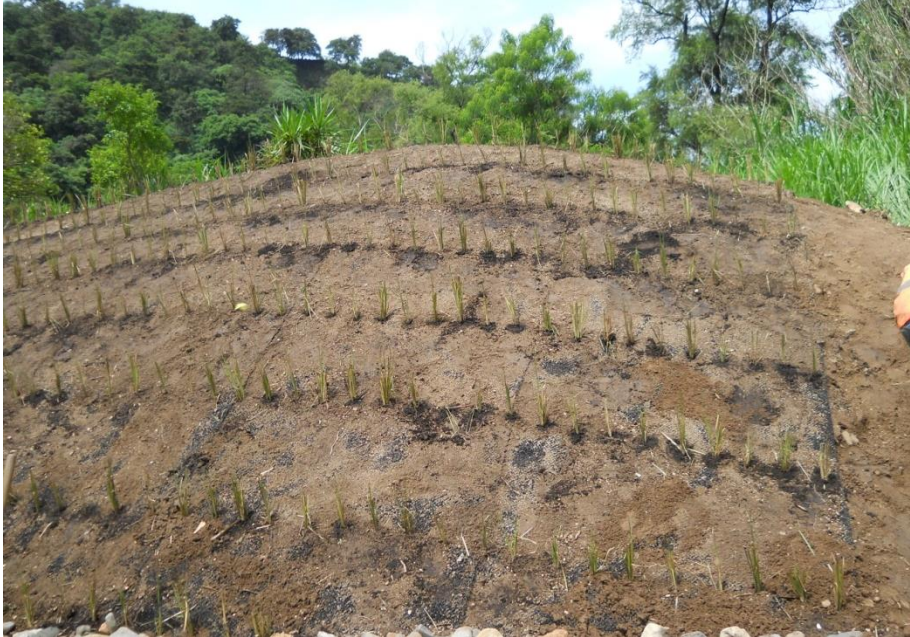
Imagen 65 Talud sembrado de Vetiver en combinación con geomanta
