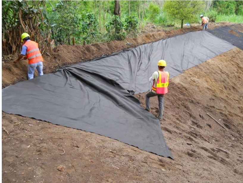
Imagen 69 Anclado e instalación del Geotextil
