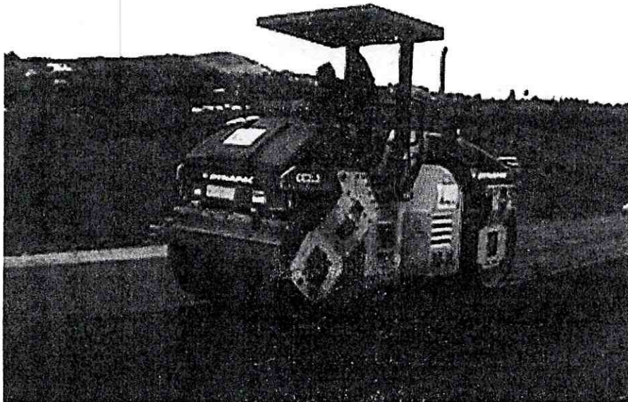
Ilustración 4.13: Proceso de compactación de mezcla asfáltica
