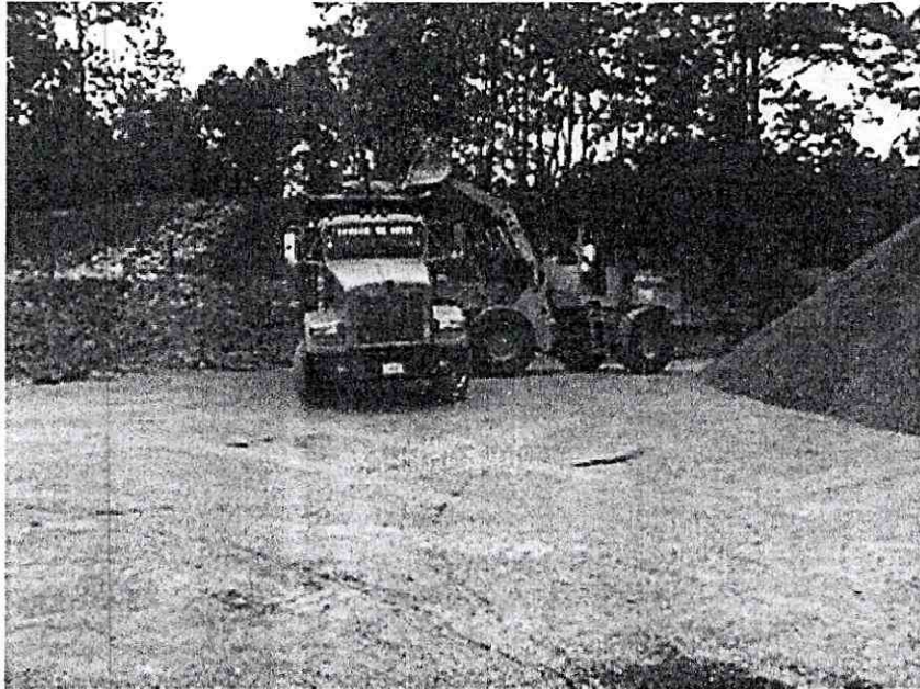
Ilustración 4.5: Cargador frontal en operación de carga de material pétreo
