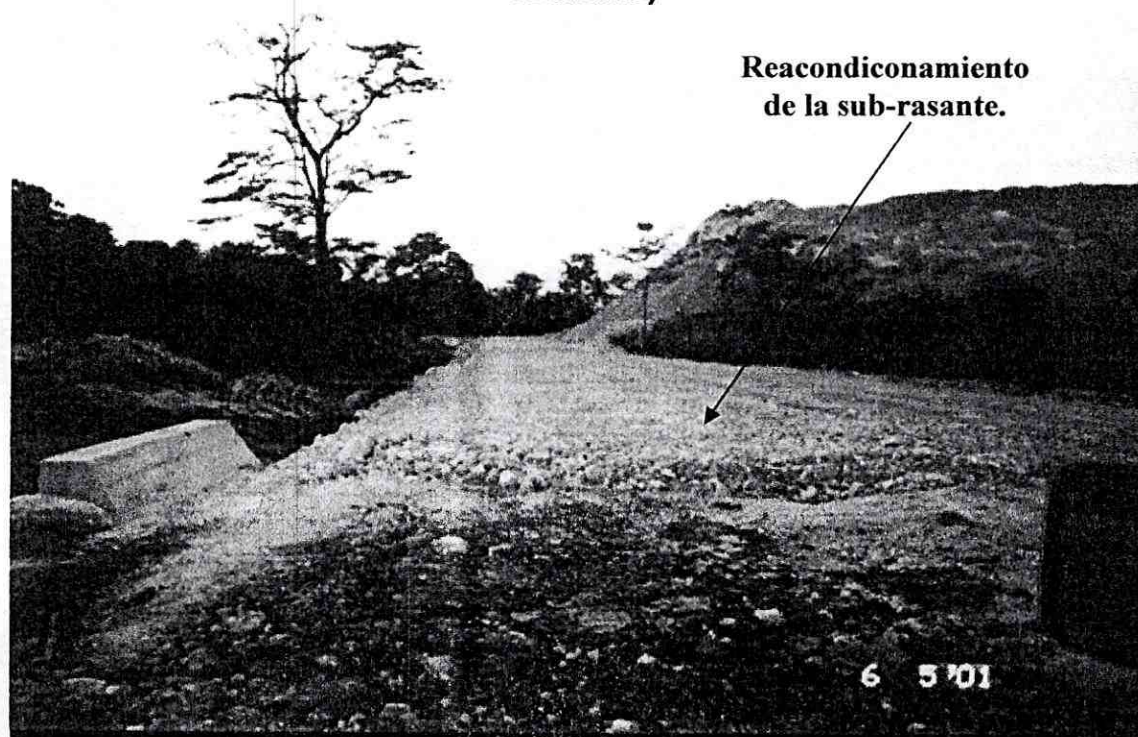
Figura 5.3: Reacondicionando la sub-rasante del cambio de línea (ángulo contrario)
