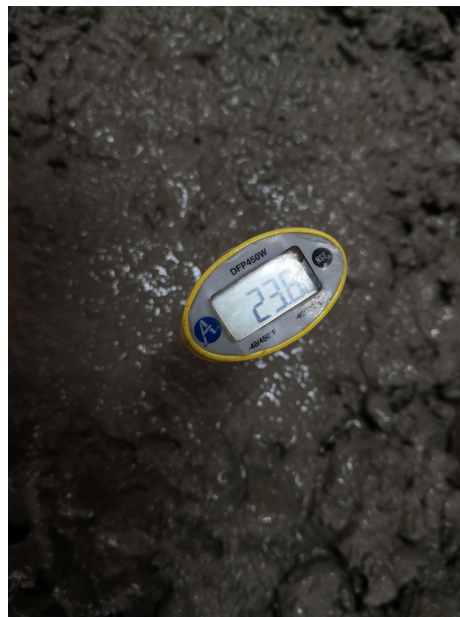
Figura 27: Medición de temperatura de concreto fresco Fuente: Elaboración propia
