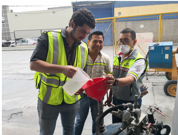
Figura 24: Adición de aditivo espumante al compresor neumático Fuente: Elaboración propia
