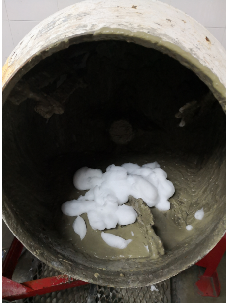
Figura 26: Mezclado de concreto celular Fuente: Elaboración propia
