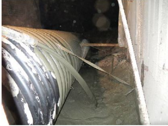
Figura 17: Concreto celular utilizado como relleno fluido Fuente: (Lazo, 2017) [14]
