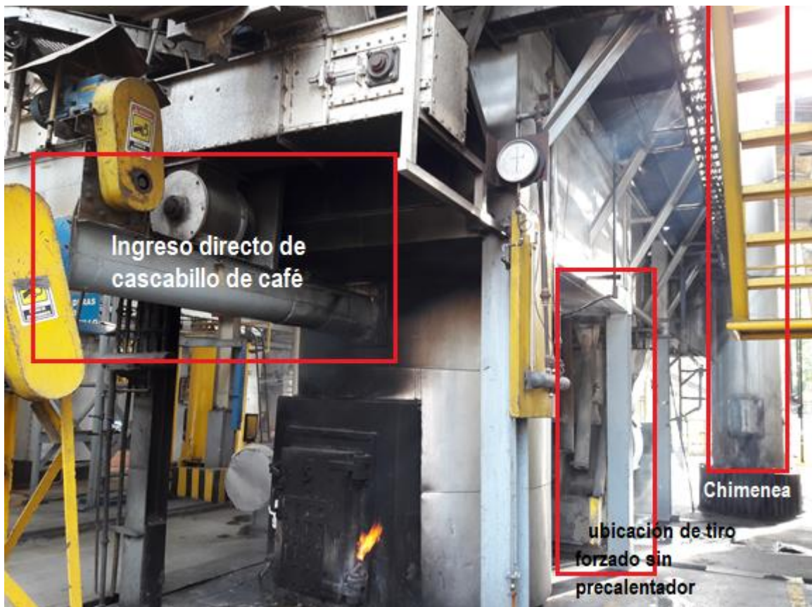
Figura 9: Perspectiva de caldera 1 en estado actual
