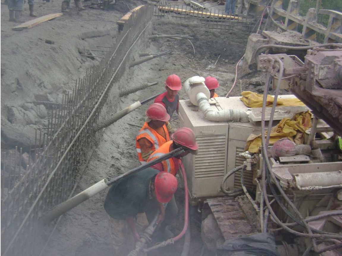
Fotografía 6.1.5 Obra de mitigación
