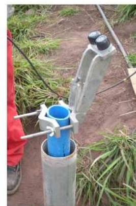
Colocación de la polea y fijador 3
