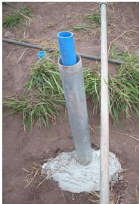
Inclinómetro Instalado Correctamente 1
