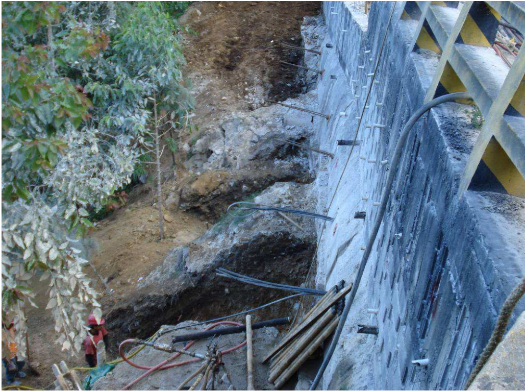
Fotografía 6.1.7 Muro anclado terminado del deslizamiento de Santa Catarina Pinula
