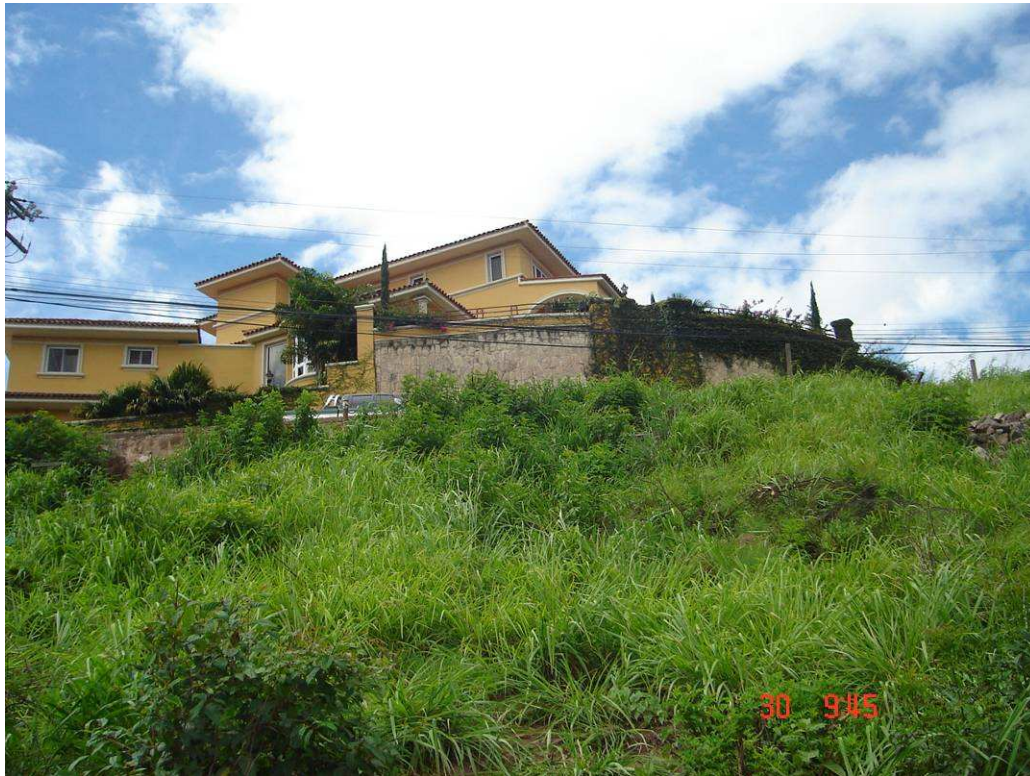
Fotografía 6.2.1 Foto del talud Las Marías
