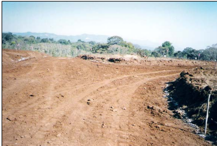
Fotografía # 01 Corte de cajuela de calle
