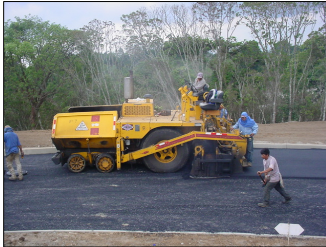
Fotografía # 38 Pavimentadora finisher
