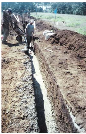
Fotografía # 16 Recubrimiento con mezclón para tubería
