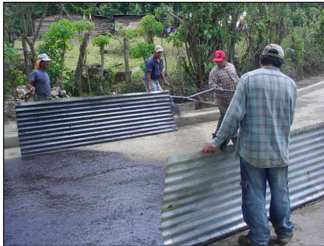
Fotografía # 22 Riego de liga donde se protege el bordillo
