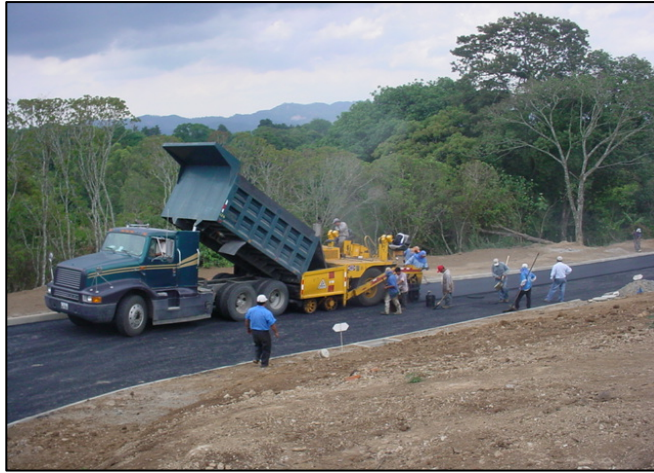
Fotografía # 23 Colocación de material asfáltico
