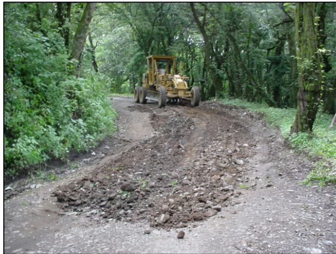
Fotografía # 18 Escarificación de calle (Tratamiento de subrasante)
