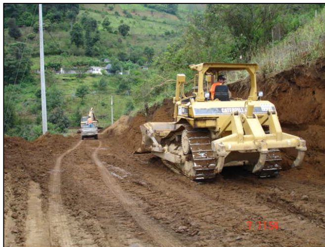
Fotografía # 31 Tractor de oruga
