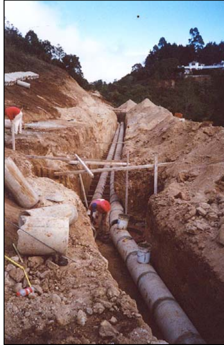
Fotografía # 05 Colocación de tubería de concreto para drenajes
