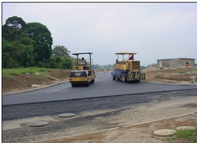
Fotografía # 24 Compactación de asfalto
