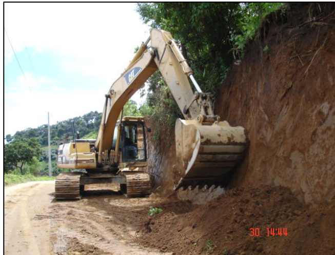
Fotografía # 32 Excavadora de oruga
