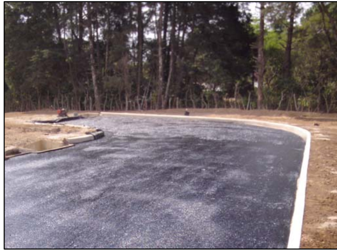
Fotografía # 21 Imprimación de calle para la protección de humedad
