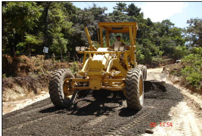
Fotografía # 20 Tendido de material para capa de base
