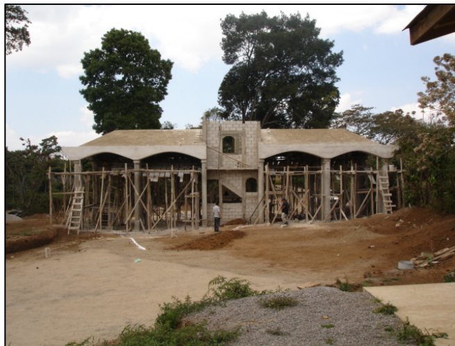
Fotografía # 30 Vista de construcción de garita de control
