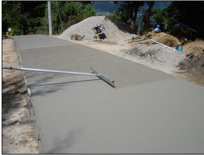
Fotografía # 28 Acabado final de losas de pavimento de concreto hidráulico
