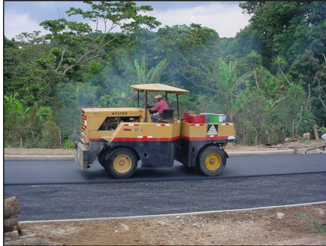
Fotografía # 36 Compactador de neumáticos
