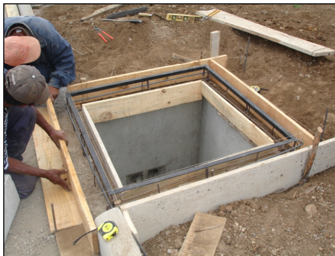
Fotografía # 15 Construcción de caja tipo H
