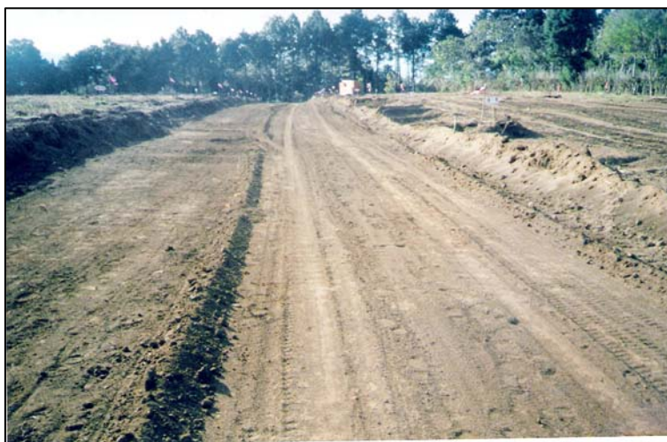
Fotografía # 17 Vista de corte de cajuela
