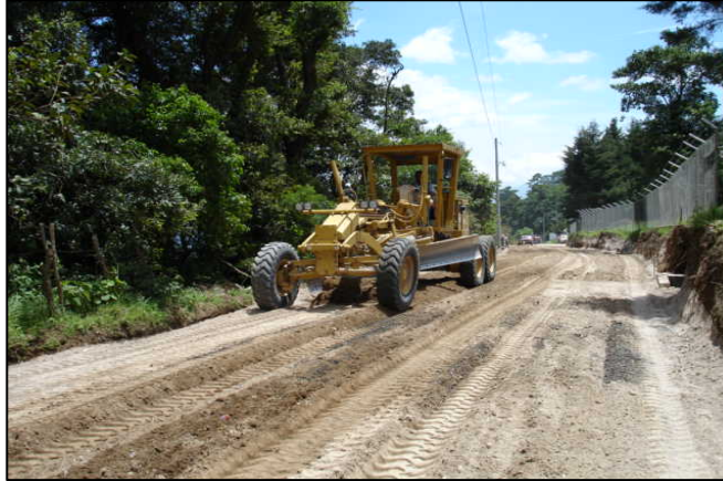
Fotografía # 19 Tendido de Material Para Capa de Subbase
