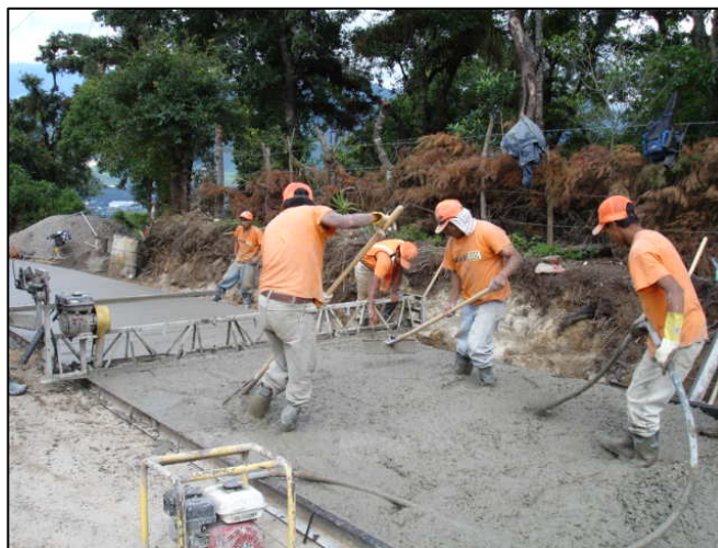
Fotografía # 27 Vista donde se muestra barra y chicote vibratorio
