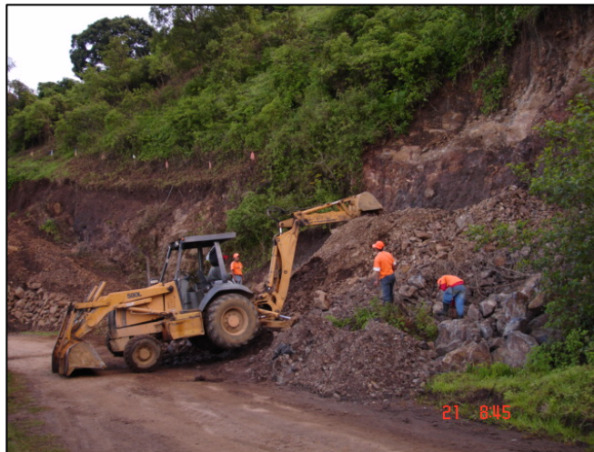
Fotografía # 34 Retroexcavadora
