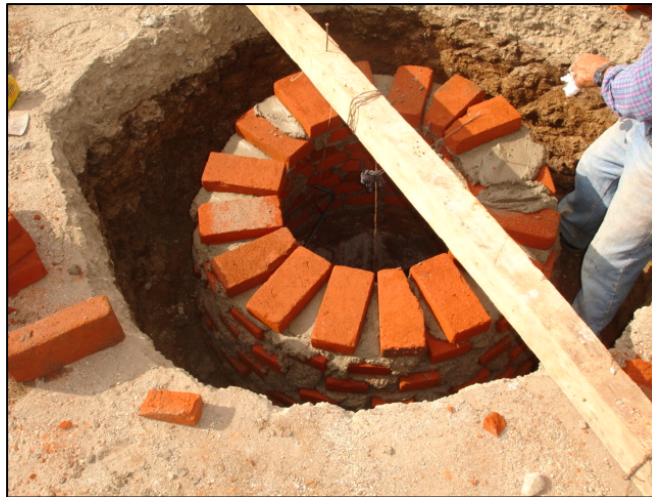
Fotografía # 07 Levantado final de brocal de pozo de visita (Posterior a la imprimación de la base)
