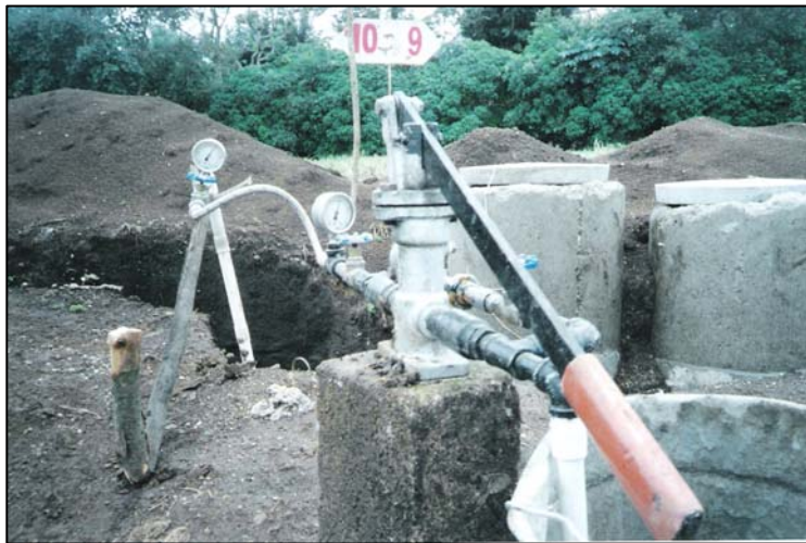
Fotografía # 14 Prueba a presión de la tubería de la red de agua potable
