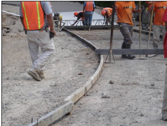
Fotografía # 26 Vista de formaleta para pavimento de concreto hidráulico
