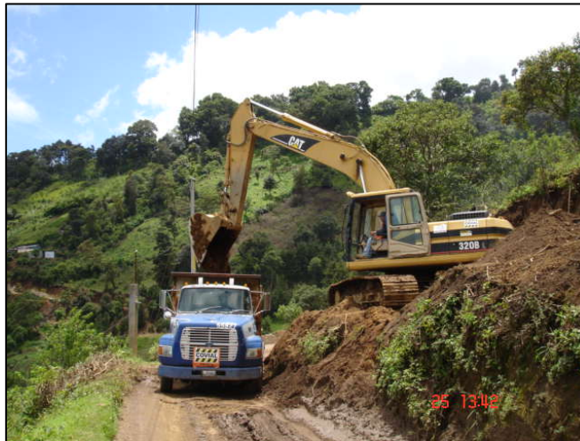
Fotografía # 02 Movimiento y transporte de materiales de excavación
