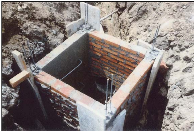
Fotografía # 10 Construcción de tragante de ladrillo tayuyo
