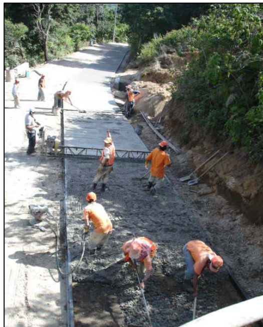
Fotografía # 25 Fundición de pavimento de concreto hidráulico
