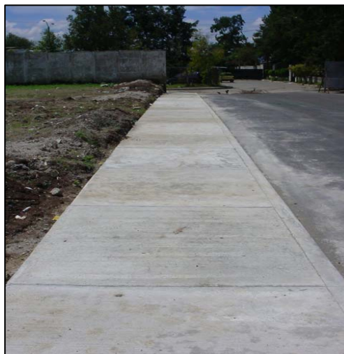
Fotografía # 29 Vista de banqueta y bordillo
