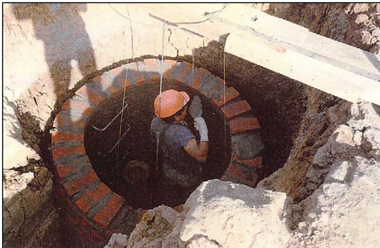
Fotografía # 06 Construcción de pozo de visita
