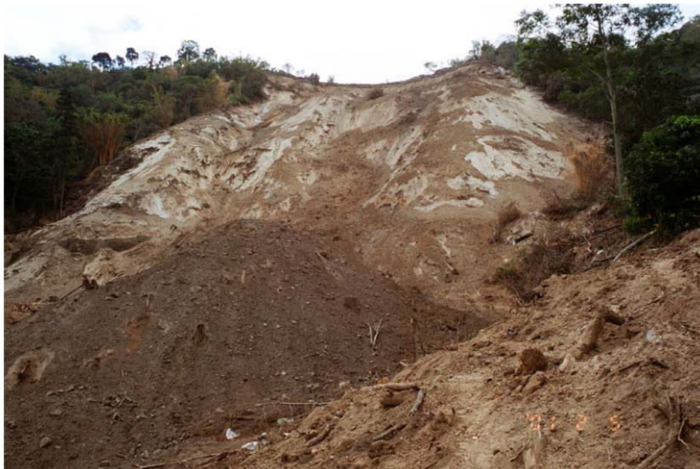
Figura 60: Deslizamiento en Las Colinas, El Salvador
