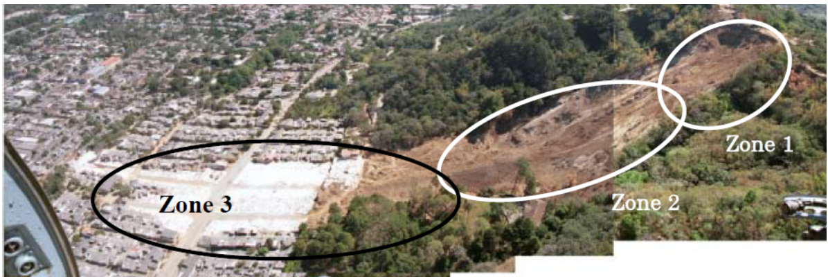
Figura 19: Deslizamiento las Colinas
