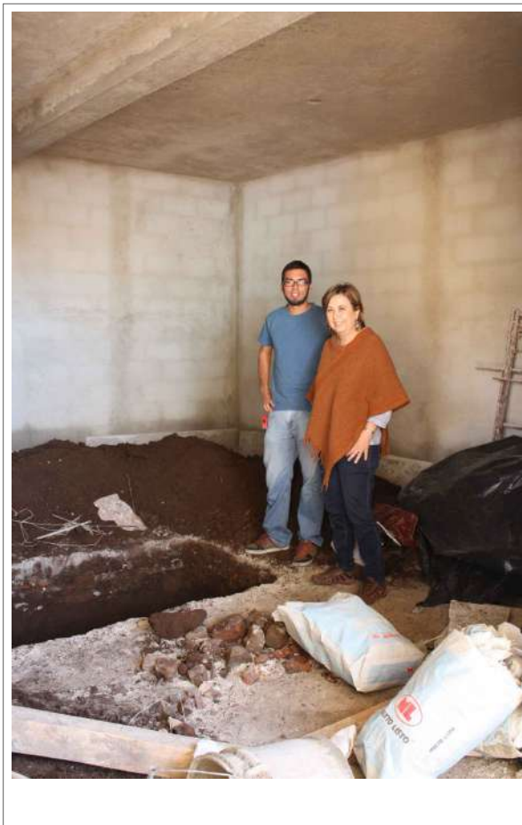
Figura 5. Carlos Fernández y Matilde Ivic durante las excavaciones de salvamento realizadas como parte de los requisitos para la construcción del edificio del Ecomuseo (Foto por Tomás Barrientos).
