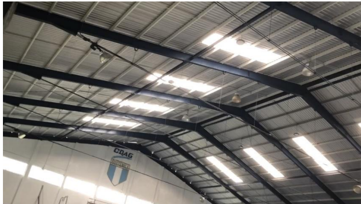
Ilustración 23. Estructura interna de cancha de baloncesto techada
