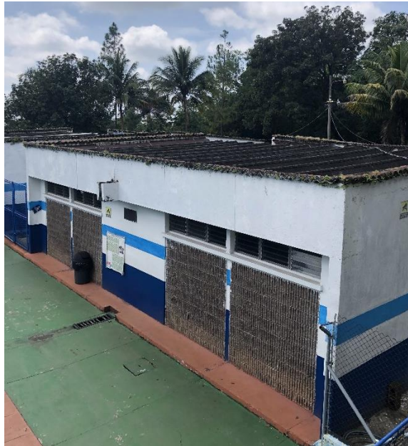
Ilustración 15. Techo de vestidores piscina olímpica
