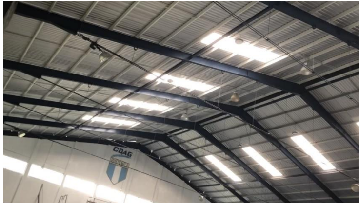
Ilustración 19. Estructura interna de cancha de baloncesto techada
