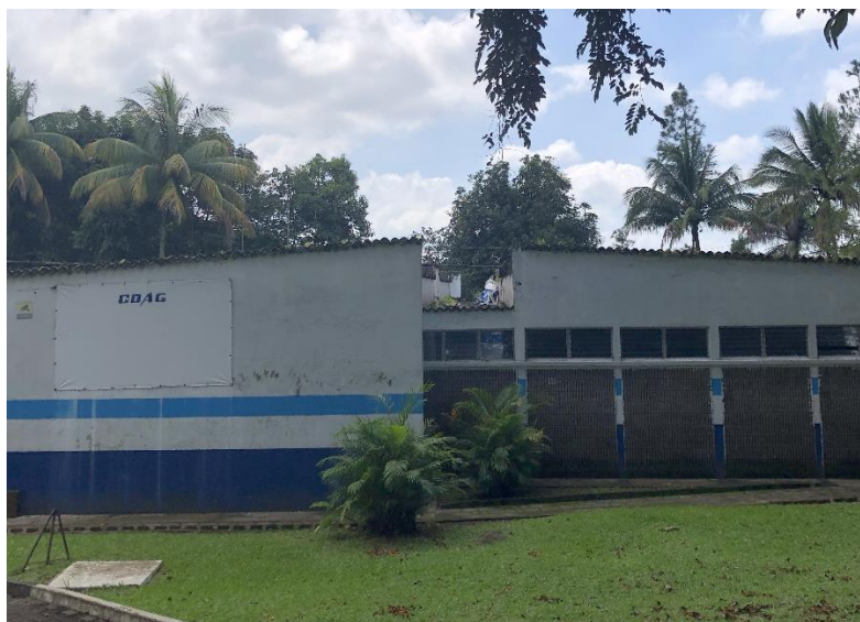
Ilustración 17. Fachada norte de vestidores piscina olímpica
