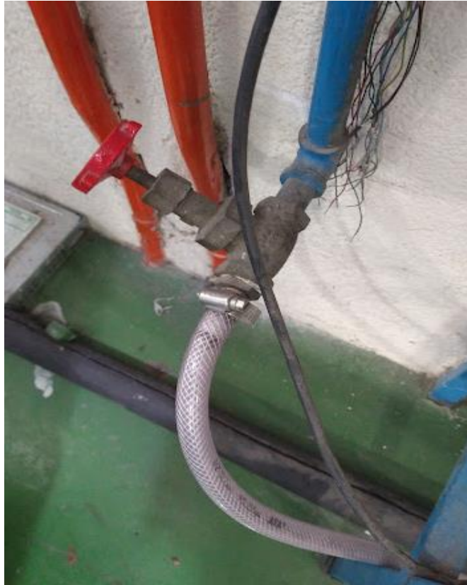
Figura 19. Cabeza de latón ½ pulgada reforzada con teflón de adaptador de manguera utilizada en el sistema de aireación.
