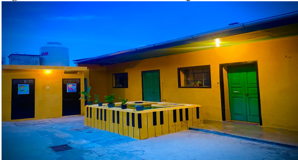
Figura 9: Patio interior del Conservatorio Regional de Música de Mixco.
