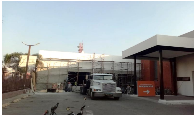
Ilustración 40. Construcción del edificio de Dollarcity
