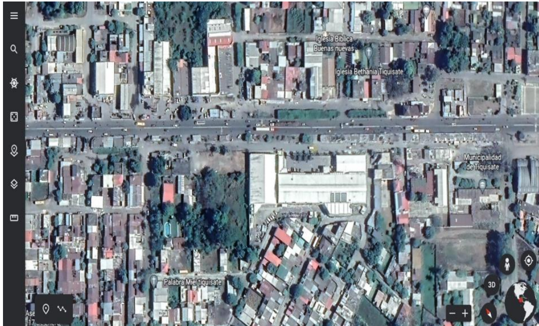
Ilustración 65. Vista aérea y orientación del Centro Comercial
