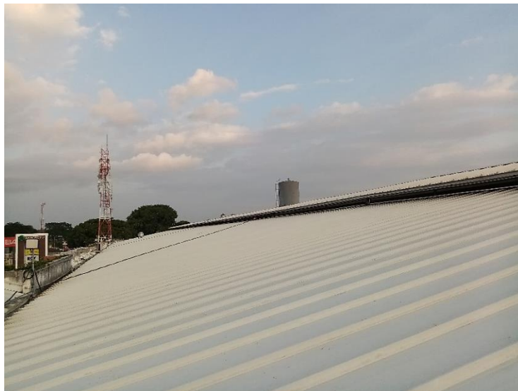
Ilustración 27. Cubierta del edificio principal
