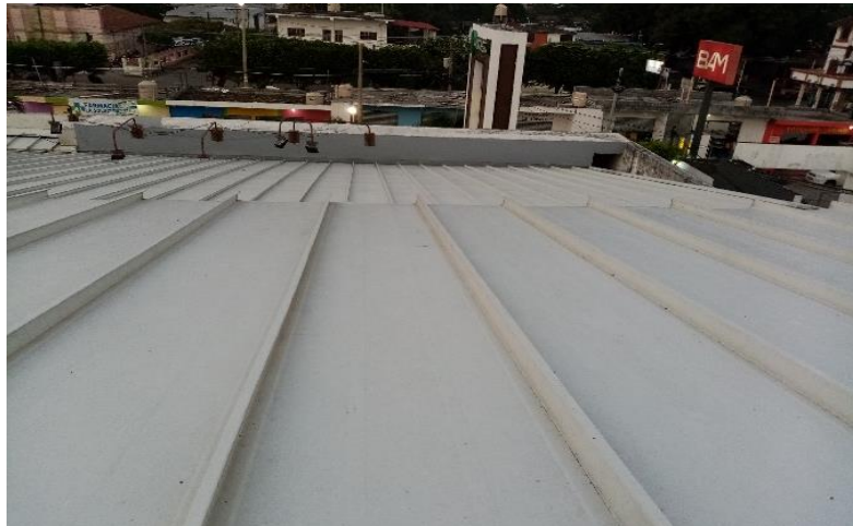
Ilustración 28. Techo tipo standing seam
