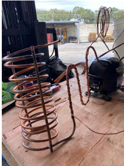
Figura 63. Intercambiador de calor conectado en la succión del compresor. (a) Tubo capilar enredado en la salida del evaporador
