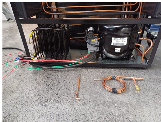
Figura 33: Corte tubería de cobre
