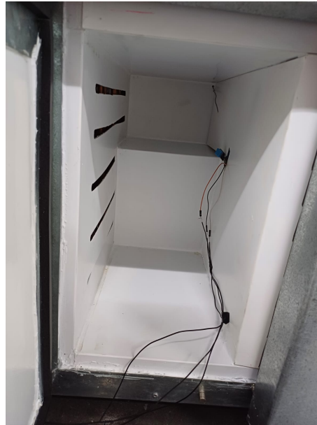
Figura 39: Colocación sensor de temperatura
