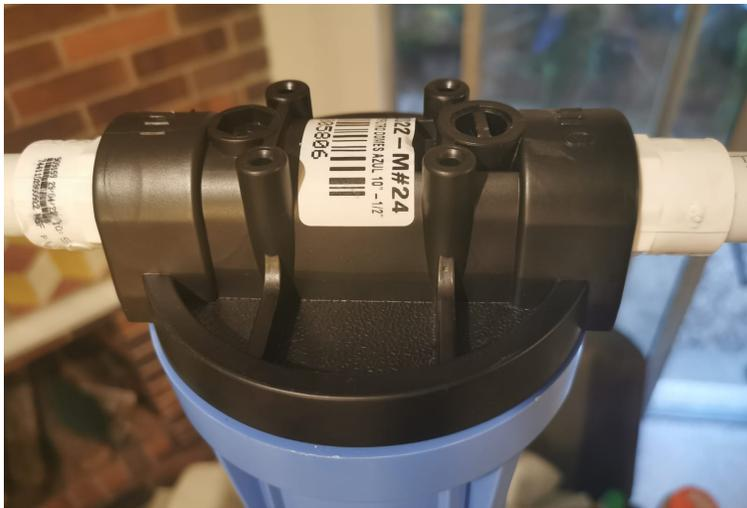
Al finalizar este primer tramo se advirtió que el peso del housing más el filtro vacío (sin agua aún); deflataban de manera significativa el sistema en la parte superior, por lo que se optó por integrar un soporte en medio de la tubería. Para ello, se empleó un adaptador tipo T, un tubo de un metro de 1" con una válvula tipo bola del mismo diámetro.
