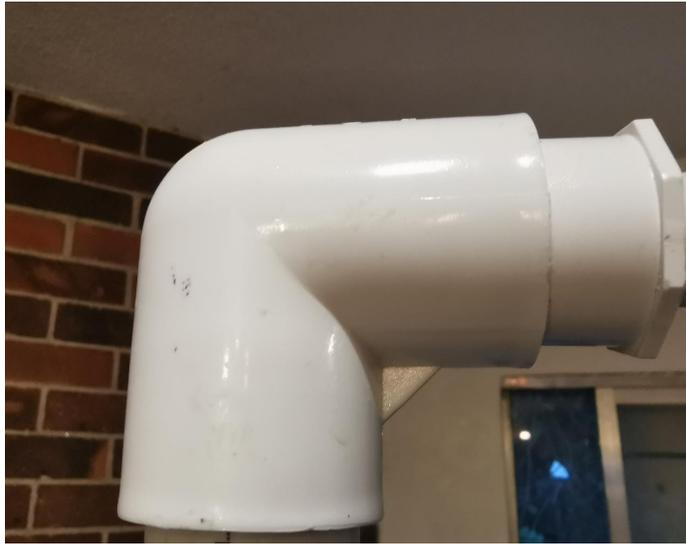
Para ello, se introdujo el cartucho del filtro dentro del housing, y se colocaron los adaptadores de cada lado del housing.
